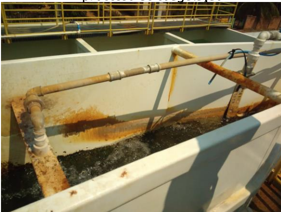
Figura 5: Adição de sulfato de alumínio no processo de coagulação
