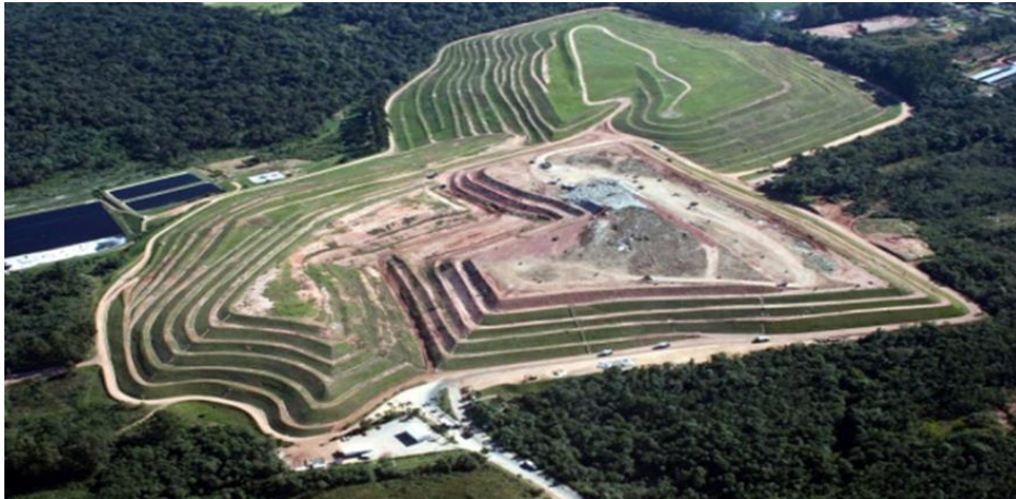
Figura 16: Aterro sanitário de Curitiba – Paraná
