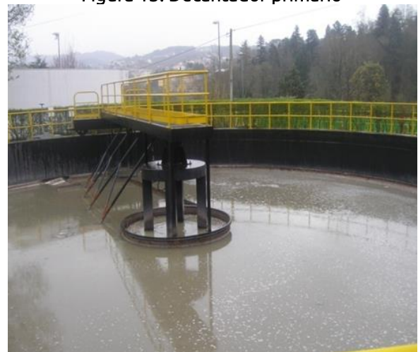
Figura 13: Decantador primário
