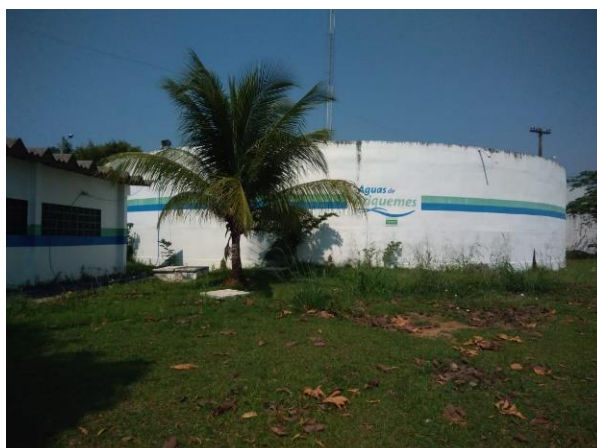
Figura 9: Reservatório apoiado em Ariquemes, Rondônia
