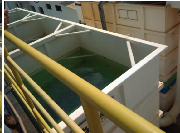
Figura 8: Filtros compostos por areia, brita e carvão ativado
