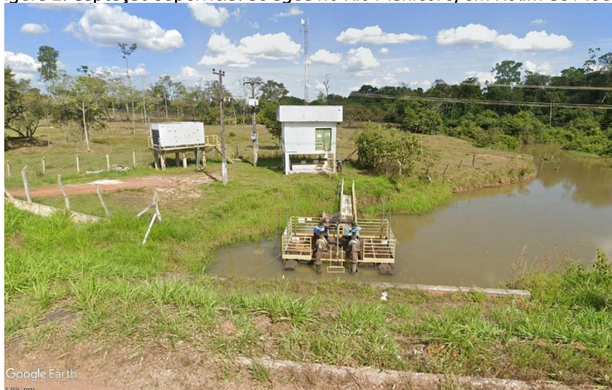
Figura 2: Captação superficial de água no Rio Manicoré, em Rolim de Moura
