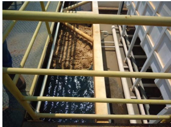
Figura 6: Processo de Floculação
