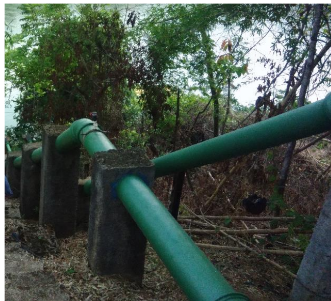
Figura 4: Adução de água bruta não enterrada no Município de Ariquemes, Rondônia
