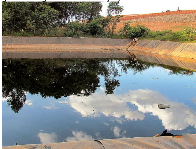
Figura 14: Lagoas de estabilização/tratamento secundário
