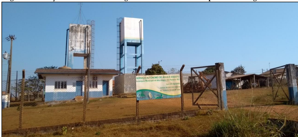
Figura 67 - Estação de Tratamento de Água do SAA da Sede Municipal de Alto Alegre dos Parecis
