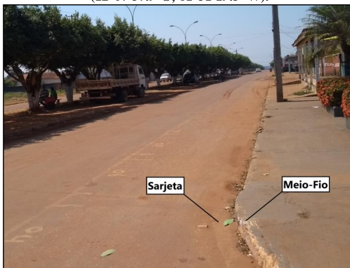
Figura 200 - Pavimentação em TSD-Asfalto com Meio-Fio e Sarjeta, na Av. Tancredo De Almeida Neves (12°07'57.9"S; 61°51'19.5"W).
