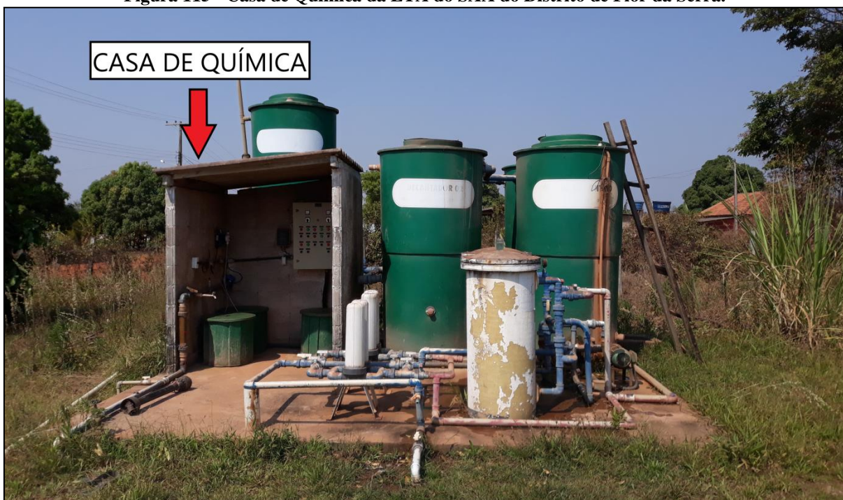
Figura 115 - Casa de Química da ETA do SAA do Distrito de Flor da Serra.
