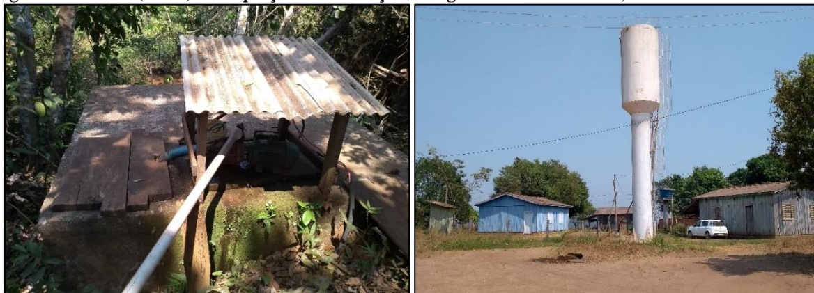
Figura 46—Local (Mina) de Captação e Reservação da Água de Abastecimento, no Distrito de Vila Bosco.
