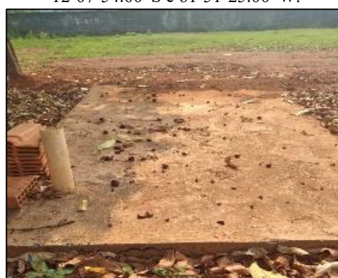
Fossa S ptica na E. M. E. F. Severino Batista Costa. 12° 7'25.21''S e 61°51'17.67''W.
