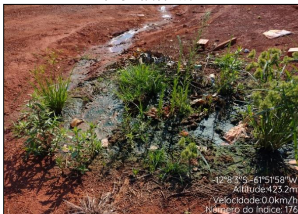
Despejo de Águas Cinzas à Céu Aberto. Coordenadas Geográficas: 12°08'03.00"S e 61°51'58.00"W.
