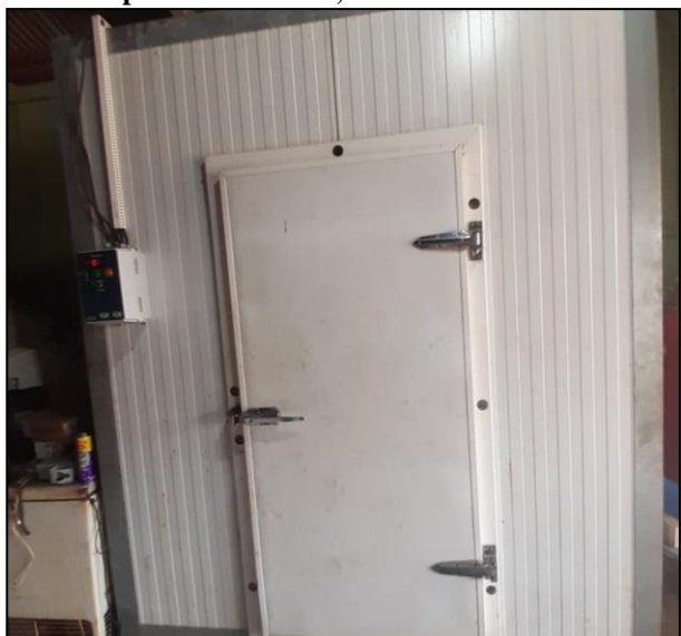
Acondicionamento dos Ossos, em Câmara Fria no Interior do Barracão.
