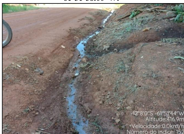
Despejo de Águas Cinzas à Céu Aberto. Coordenadas Geográficas: 12°08'03.00"S e 61°51'09.00"W.
