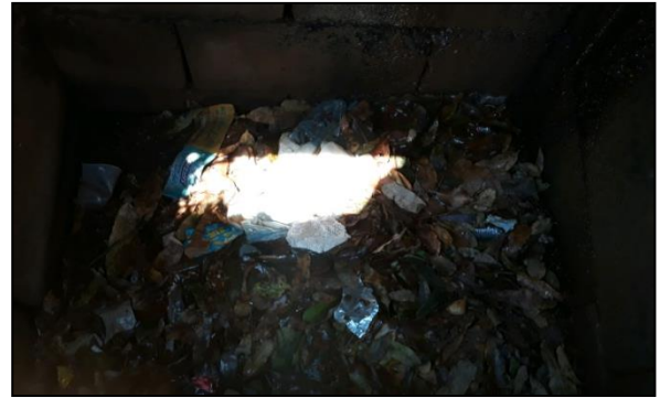
Acúmulo de Resíduos no Interior de Boca de Lobo, na Av. Tancredo de Almeida Neves. 12°07'57.92"S e 61°51'23.74"W.
