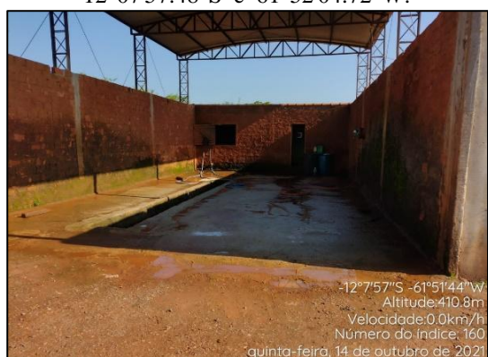
Lavador - Av. Tancredo Neves. 12°07'57.00"S e 61°51'44.00"O.
