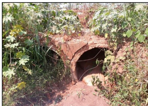
Av. Tancredo de Almeida Neves. 12°08'00.01"S e 61°51'41.27"W.
