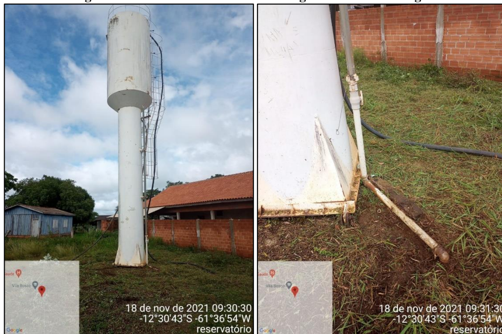
Figura 136 - Reservatório Elevado e Registro de Saída de Água.
