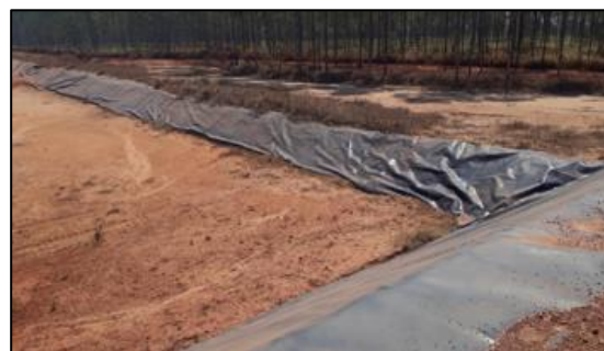
Sistema de Impermeabilização das Células.
