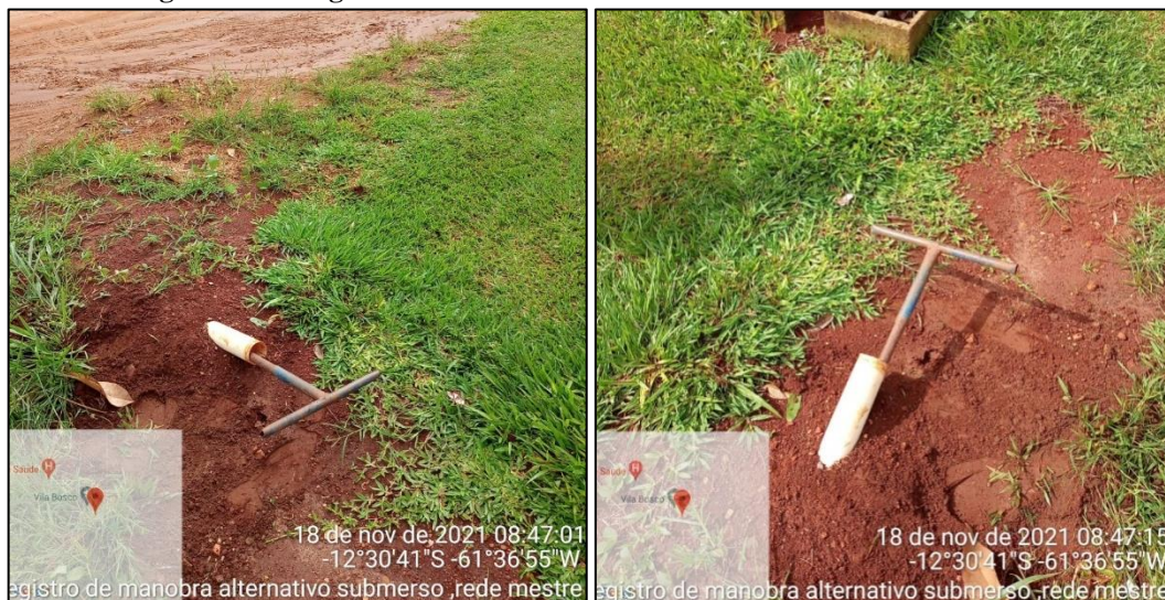
Figura 138 - Registro de Manobra Alternativo Submerso – Rede Mestre.
