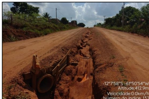
Av. Tancredo de Almeida Neves. 12°7'58"S e 61°50'54"W.
