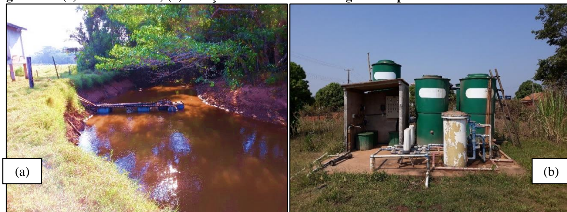
Figura 45—(a) Rio Vermelho; (b) Estação de Tratamento de Água Compacta – Distrito de Flor da Serra.
