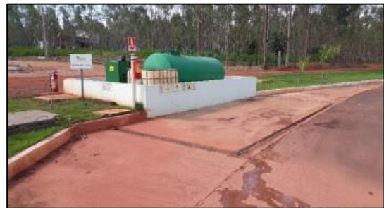
Posto de Abastecimento.
