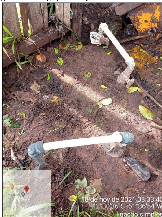
Figura 140 - Ligações Simples Sem Micromedição.
