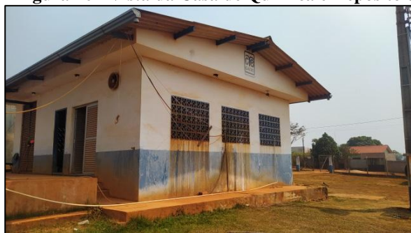
Casa de Química.
