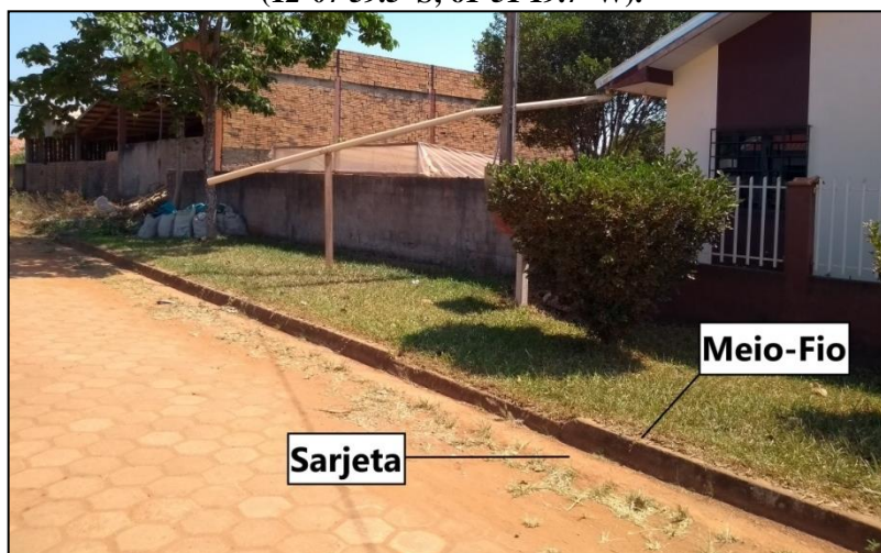
Figura 201 - Pavimentação em Blocos Sextavados com Meio-Fio e Sarjeta, na Avenida Ulisses Guimarães (12°07'59.5"S; 61°51'19.7"W).
