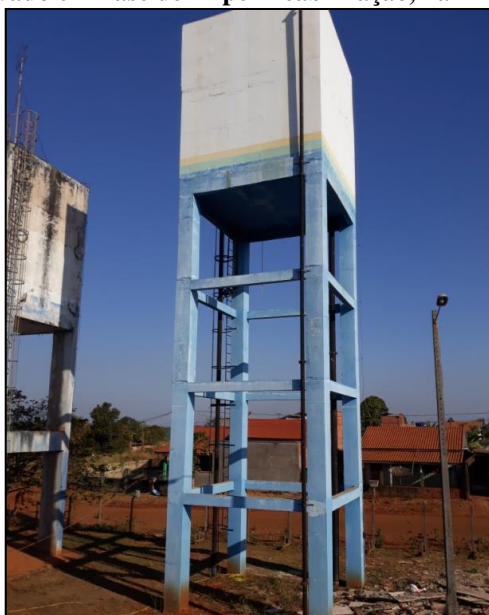
Figura 89 - Reservatório Elevado em Fase de Impermeabilização, na Área da ETA da Sede Municipal
