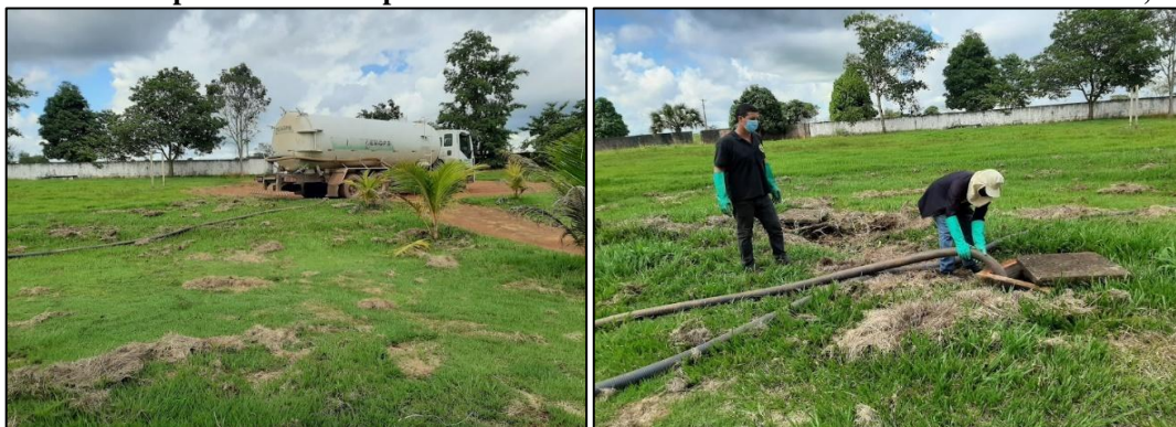
Figura 175 - Limpeza da Fossa Séptica da E. M. E. F. Marcelo Gama - Área Rural - Linha 176, km 05
