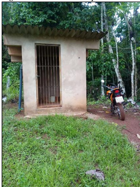
Figura 130 - Casa de Proteção dos Painéis.
