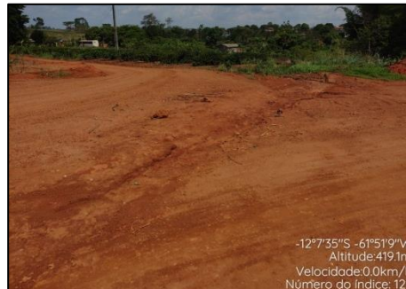
Av. Tancredo de Almeida Neves. 12°07'35"S e 61°51'9"W.
