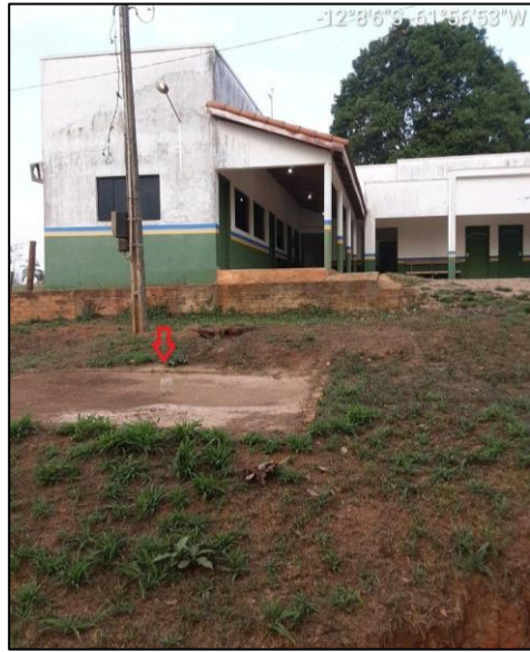
Fossa Rudimentar na Unidade de Saúde P44 – Área Rural.
