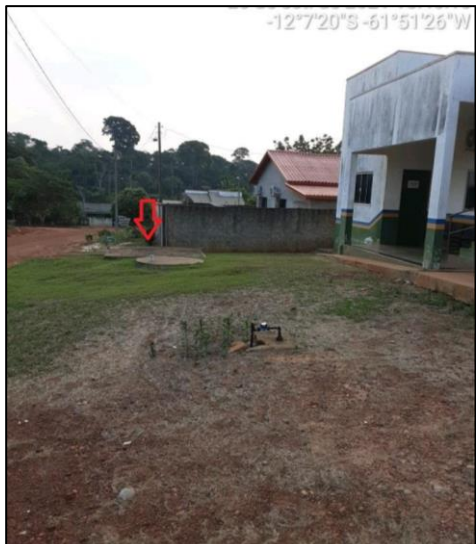
Fossa Rudimentar na UBS Jardim das Palmeiras – Sede Municipal.
