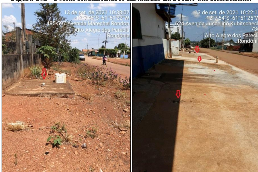
Figura 162 - Fossas Rudimentares Instaladas na Frente das Residências.
