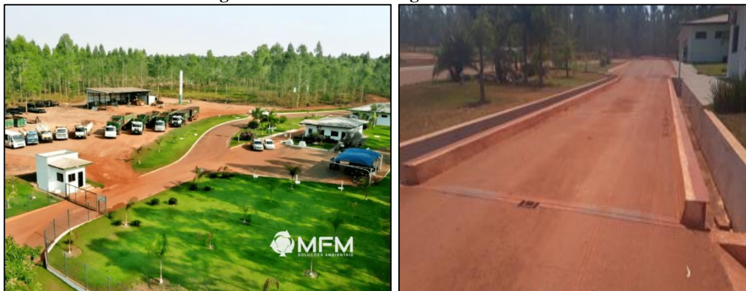
Figura 230 -Local de Pesagem dos Resíduos.
