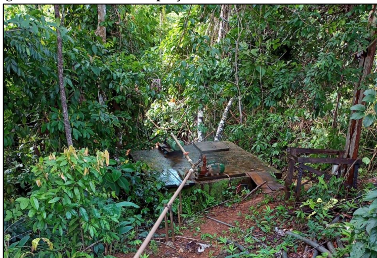
Figura 126 - Nascente de Captação da SAC do Distrito de Vila Bosco.
