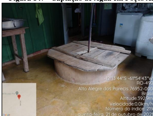
RO-490 – Poço Amazonas.
