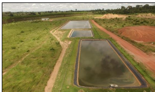
Estação de Tratamento de Efluentes – ETE (Anaeróbia+ Anaeróbia+ Facultativa).
