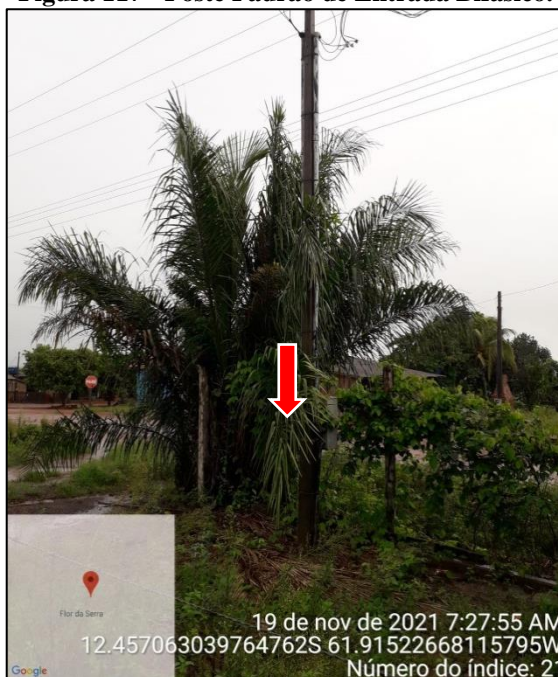
Figura 117 - Poste Padrão de Entrada Bifásico.
