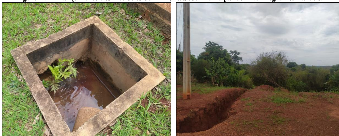
Figura 254 - Lançamento dos Resíduos da ETA, na Sede Municipal de Alto Alegre dos Parecis.
