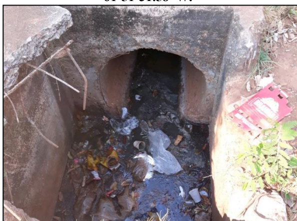
Ligação Clandestina de Esgoto em Boca de Lobo. Coordenadas Geográficas: 12°07'59.53"S e 61°51'28.44"W.
