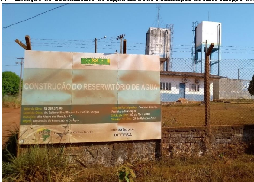
Figura 44—Estação de Tratamento de Água na Sede Municipal de Alto Alegre dos Parecis.
