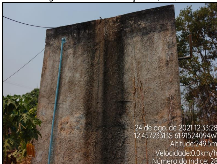
Figura 114 - Reservatório Apoiado (RAP).
