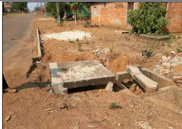
Erosão na pavimentação e falta de grelha de proteção da boca de lobo, na Rua 06 esquina com Rua 11.
