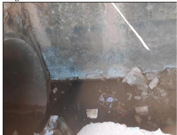
Lançamento de esgoto no sistema de drenagem, na RO-489, Distrito Novo Paraíso;
