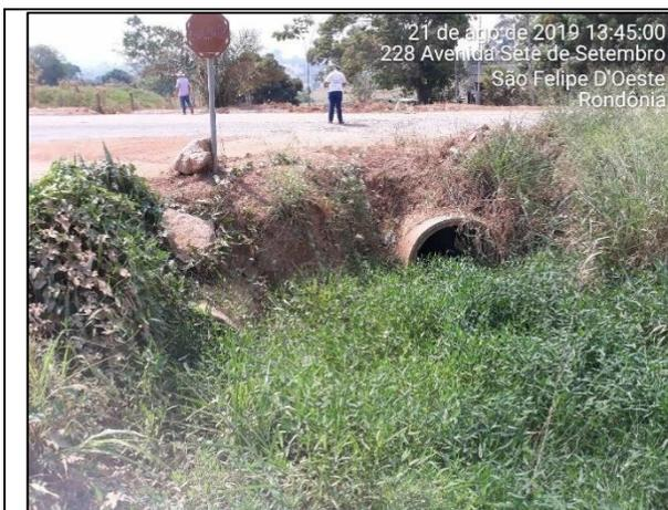
Manilhas de concreto armado, sendo uma de 100cm de diâmetro e outra de 120cm.
