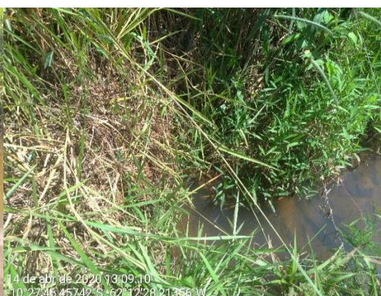
P 018- Tubo de Concreto (Linha 62) Estado de conservação: apresenta bom estado de conservação, não apresenta sinais de rachaduras, fendas, furos ou outras avarias de natureza estrutural.
