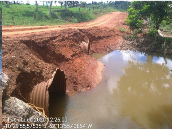
P 06 – Dois Tubo Armco (Linha 62)
