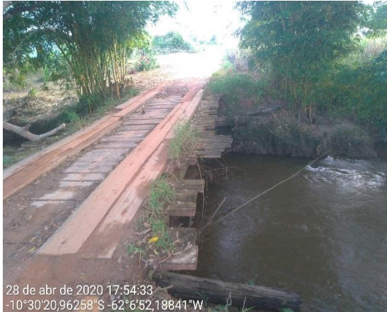
P 043 - Ponte de madeira linha 201 sentido linha 153.
