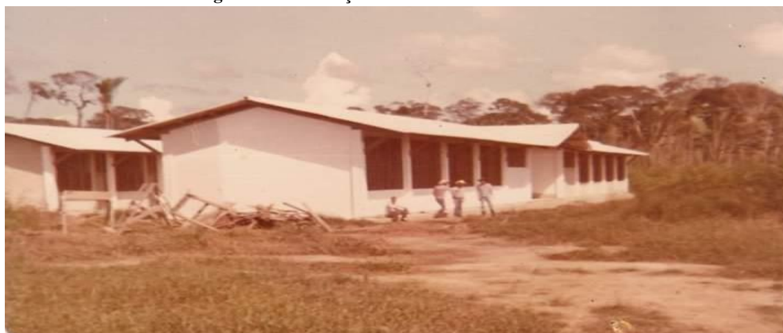
Figura 5 - Construção da Escola Estadual Tubarão
