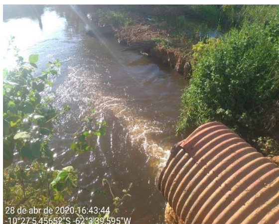
P 025- Tubo armco (Linha 202 sentido linha 153.)
