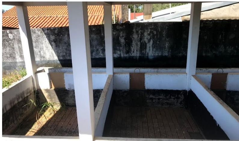
Figura 77 - Leitos de secagem do lodo
