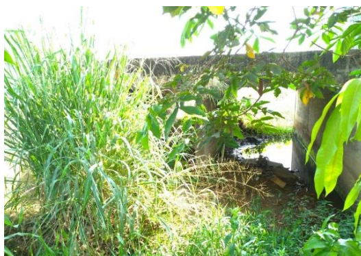
Fundo de Vale 3 - Rua 13 de Fevereiro – SETOR 4 10^{\circ}25'43.28''S e 62^{\circ}7'41.83''W Galeria de concreto armado Bom estado de conservação
