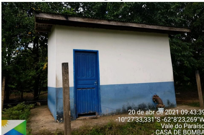
Figura 67 - Vista do Abrigo do painel de comando
