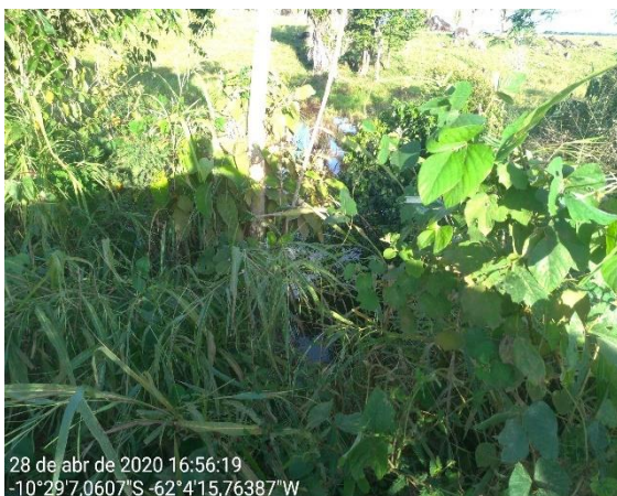
P 027- Tubo de concreto linha 202 - sentido linha 153.
