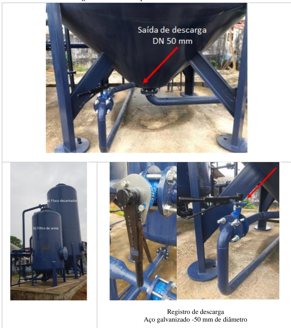
Figura 74 - Nova Estação de Tratamento Licitada
