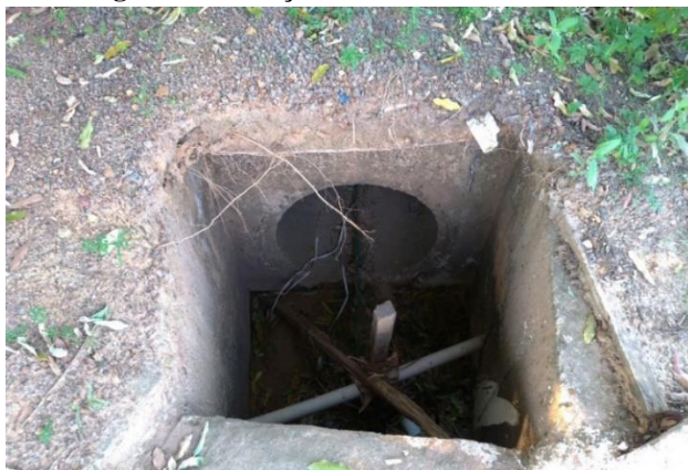
Figura 161 - Poço de Visita 1 - Av. Paraná
