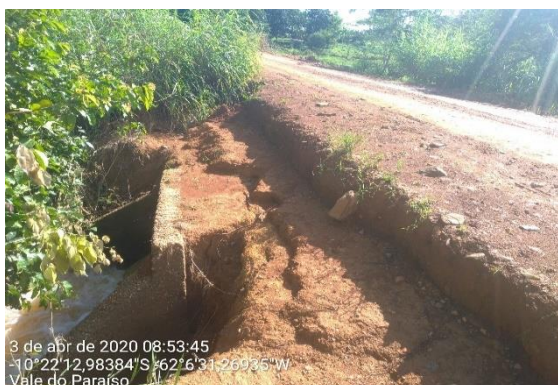
P 03 - Galeria de Concreto Armado - RO - 470 (Linha 200)
