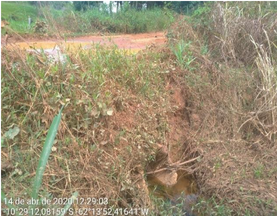
P 07 – Tubo de Concreto (Linha 62)
