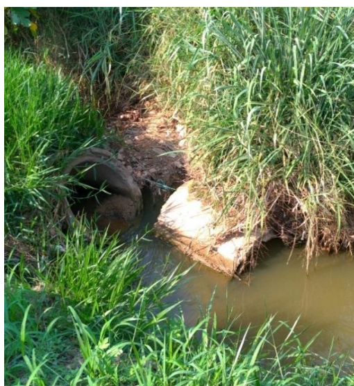
F03 - Bueiro Av. Paraná 10°42'92.96"S e 62°13'00.48"W Tubo de concreto
