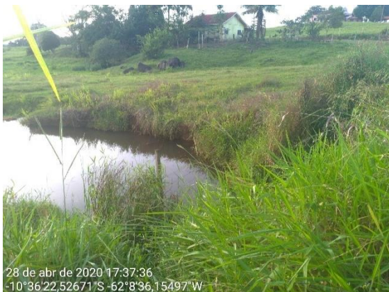
P 041 – Tubo Armco linha 201 sentido linha 153. Estado de conservação: Apresenta bom estado de conservação, com bordas pouco desbastadas e
