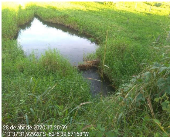
P 035- Tubo de concreto linha 202 - sentido linha 153.
