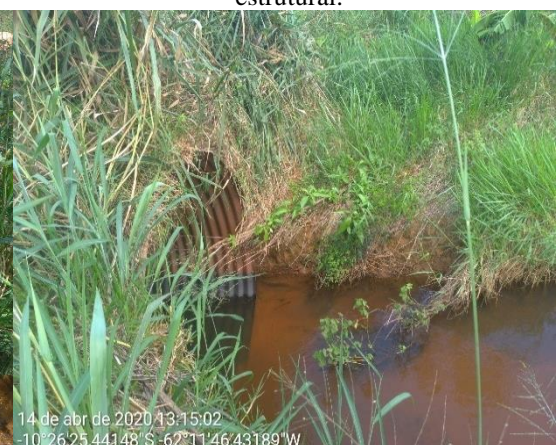
P 020 - Tubo Arco (Linha 24) Estado de conservação: Apresenta bom estado de conservação, bordas sem desgaste, ausência de
