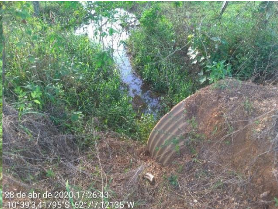
P 038 - Tubo Armco linha 202 sentido linha 153. Estado de conservação: Apresenta bom estado de conservação, com bordas pouco desbastadas e sem nenhum sinal de danificação interna que comprometa a estrutura (furos, rachaduras, fendas, etc). A área ao redor está com vegetação alta, o que pode comprometer suas funções.
