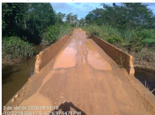
P 01 - Ponte de Concreto Armado - RO-470 (Linha 200, Rio Montevidéu)
