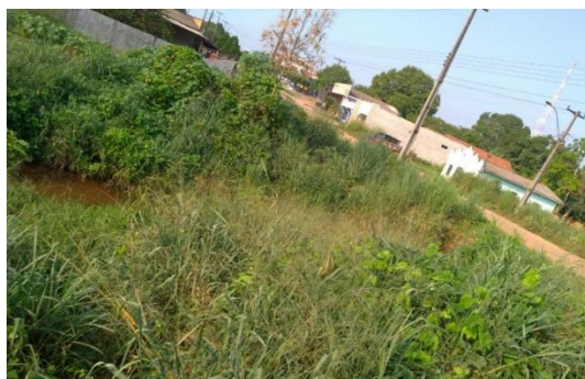
Fundo de Vale 1 - Av. Paraná – SETOR 2 10^{\circ}25'28.04''S e 62^{\circ}7'44.66''W Galeria de concreto armado Bom estado de conservação
