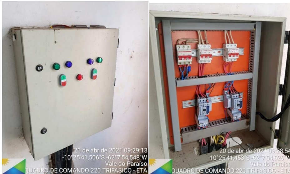
Figura 88 - Painel de Comando da EETA
