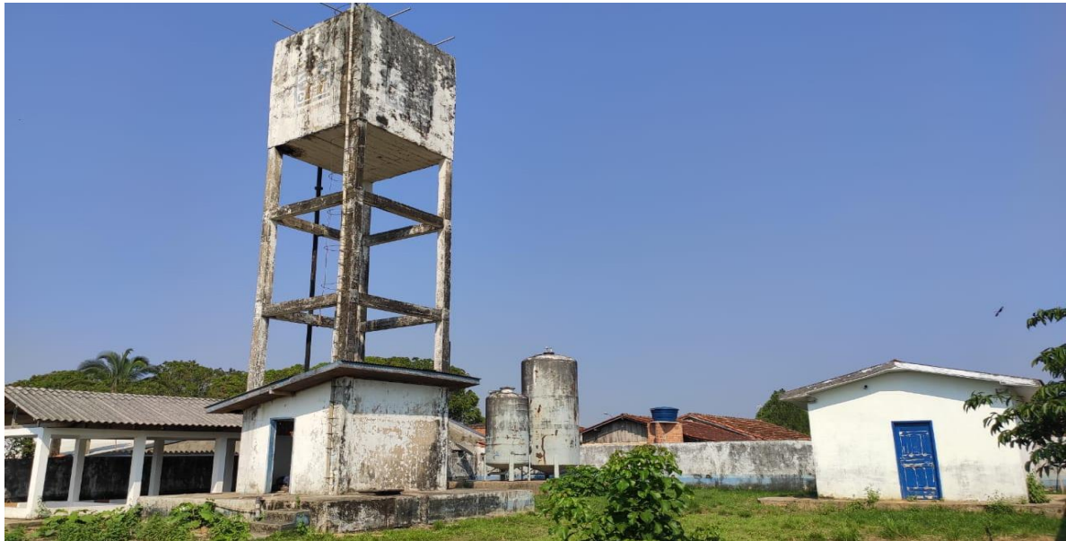
Figura 71 - Estação de Tratamento de Vale do Paraíso
