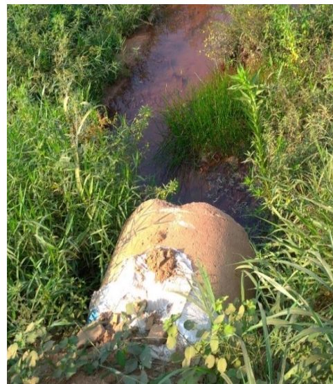
F04 - Bueiro Rua Projetada 02 10°42'42.40"S e 62°12'85.39"W Tubo de concreto
