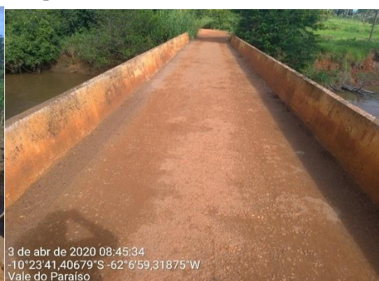
P 02 - Ponte de Concreto Armado - RO - 470 (Linha 200, Rio Paraíso)
