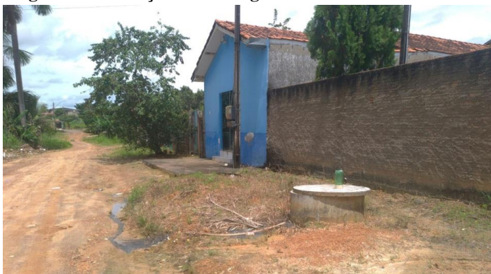
Figura 123 - Lançamento de águas cinzas na Rua Primavera
