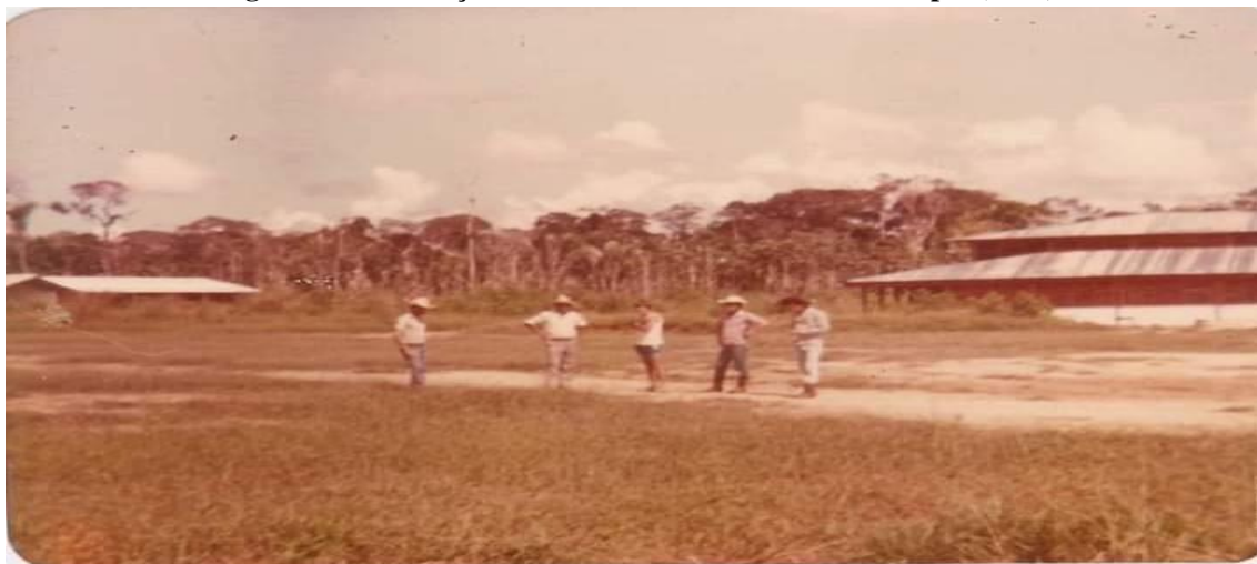
Figura 3 - Construção do Centro Administrativo Municipal (1984)
