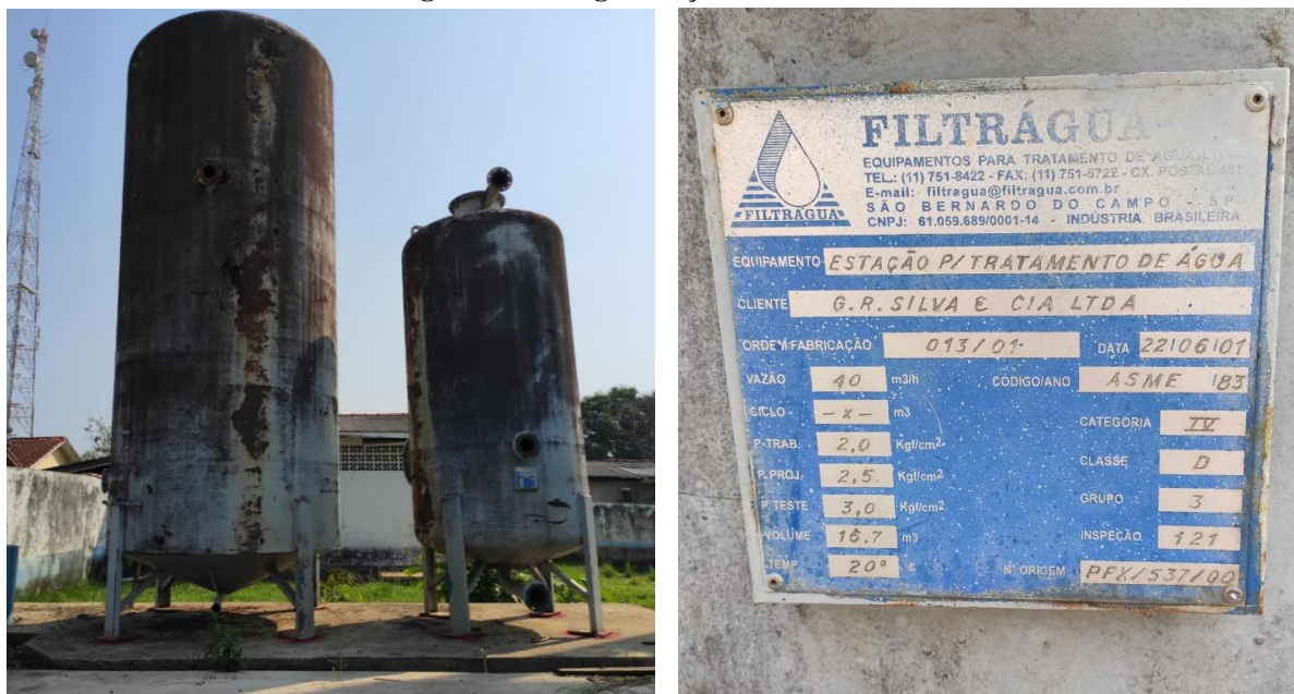
Figura 73 - Antiga Estação de Tratamento
