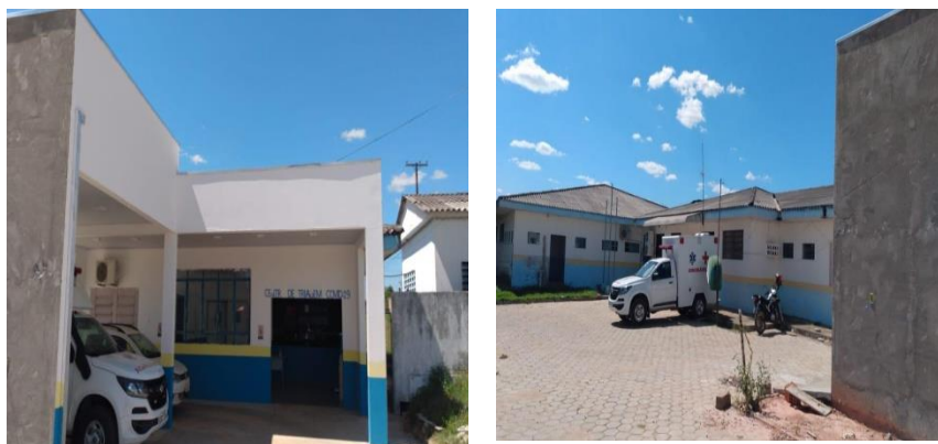
Figura 203 - Hospital de Pequeno Porte de Vale do Paraíso (HPP)
