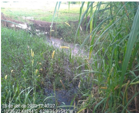
P 045 – Tubo de concreto linha 201 sentido linha 153.
