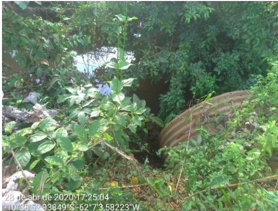
P 037 - Tubo Armco linha 202 sentido linha 153. Estado de conservação: Apresenta bom estado de conservação, com bordas pouco desbastadas e sem nenhum sinal de danificação interna que comprometa a estrutura (furos, rachaduras, fendas, etc). A área ao redor está com vegetação alta, o que pode comprometer suas funções.
