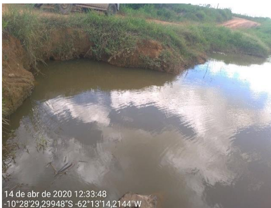
P 09- Tubo de Concreto, Instalado Afogado (Linha 62)
