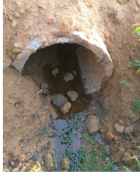
F06 - Rua Projetada 06 10°42'81.75"S e 62°13'81.57"W Tubo de concreto Estado de conservação regular
