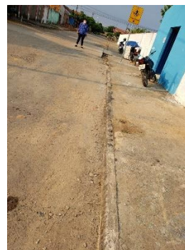
Pavimentação com meio-fio
