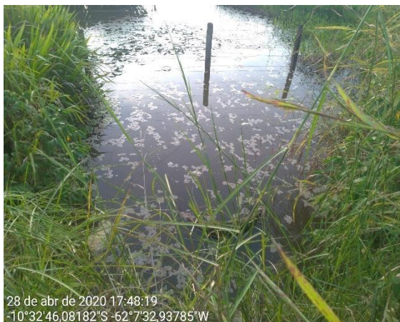
P 053 – Tubo de concreto linha 201 sentido linha 153.
