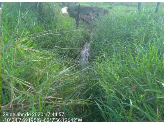
P 042 – Tubo concreto linha 201 sentido linha 153.
