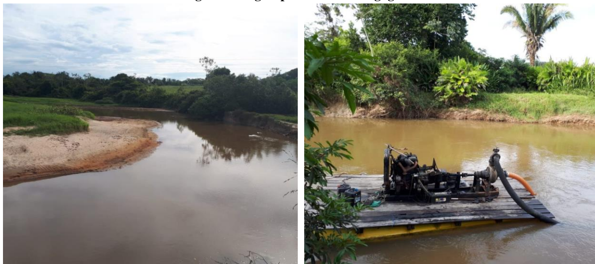
Figura 18 - Igarapé Paraíso e Dragagem
