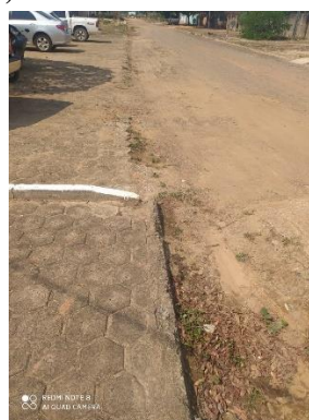
Pavimentação com meio-fio
