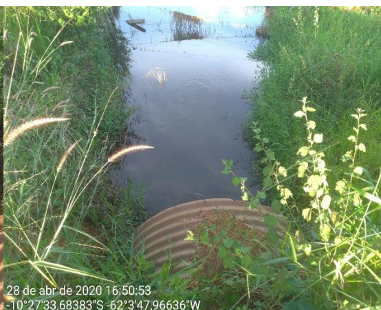
P 026- Tubo armco (Linha 202 sentido linha 153.)
