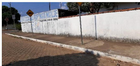
Pavimentação com meio-fio
