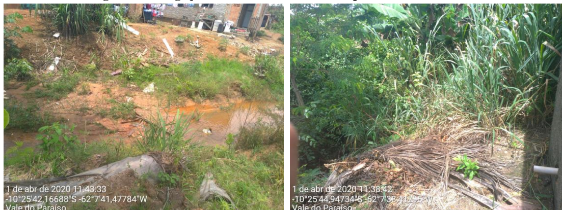
Figura 168- Ligações Clandestinas no Município de Vale do Paraíso
