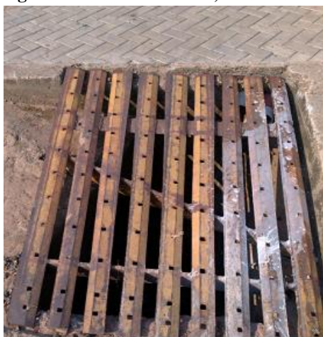
Figura 162 - Boca de Lobo, Av. Paraná
