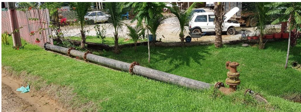
Figura 69 - Adutora de água bruta
