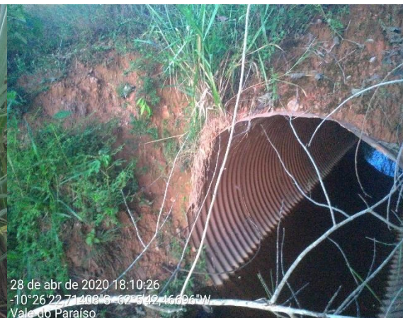
P 046 - Tubo armco (localização)
