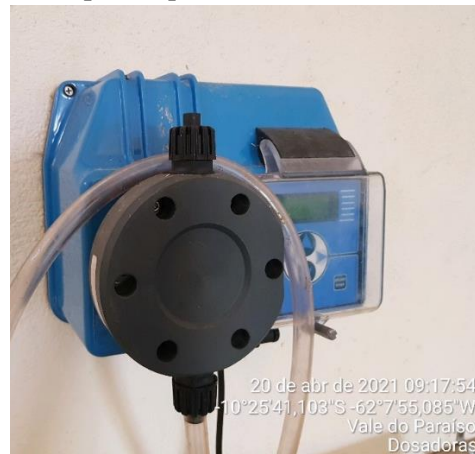
Figura 82 - Bombas dosadoras de compostos químicos
