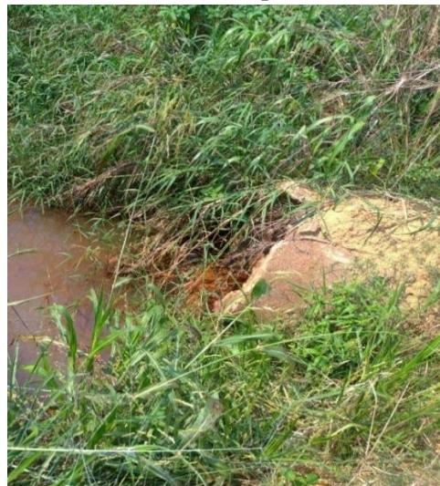
F02 - Bueiro Rua dos Cedros 10°42'89.59"S e 62°12'91.71"W Tubo de concreto
