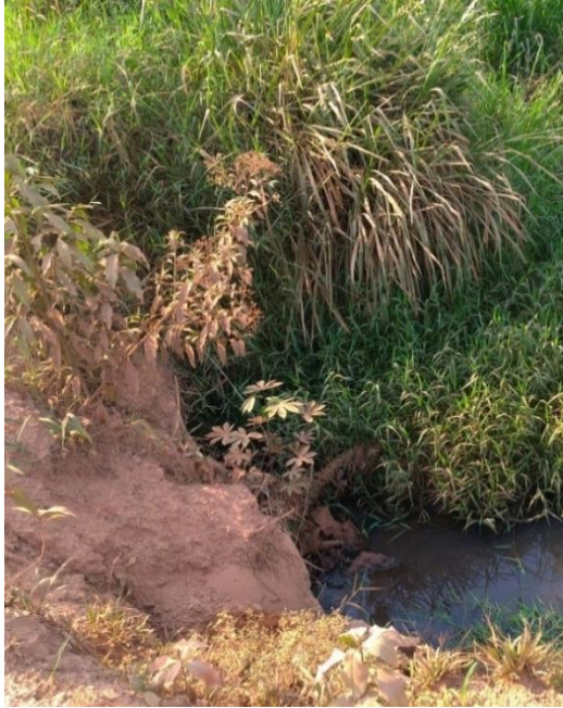
F05 - Bueiro RO 472 (201) 10°42'32.41"S e 62°12'73.97"W Tubo de concreto Estado de conservação regular
