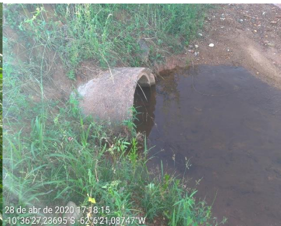
P 034- Tubo de concreto linha 202 - sentido 153.
