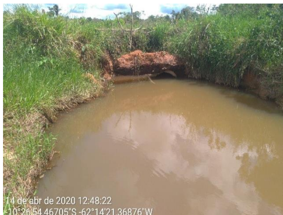
P 015 – Tubo de Concreto (Linha 20 da 62) Estado de conservação: apresenta bom estado de conservação, não apresenta sinais de rachaduras, fendas, furos ou outras avarias de natureza estrutural.
