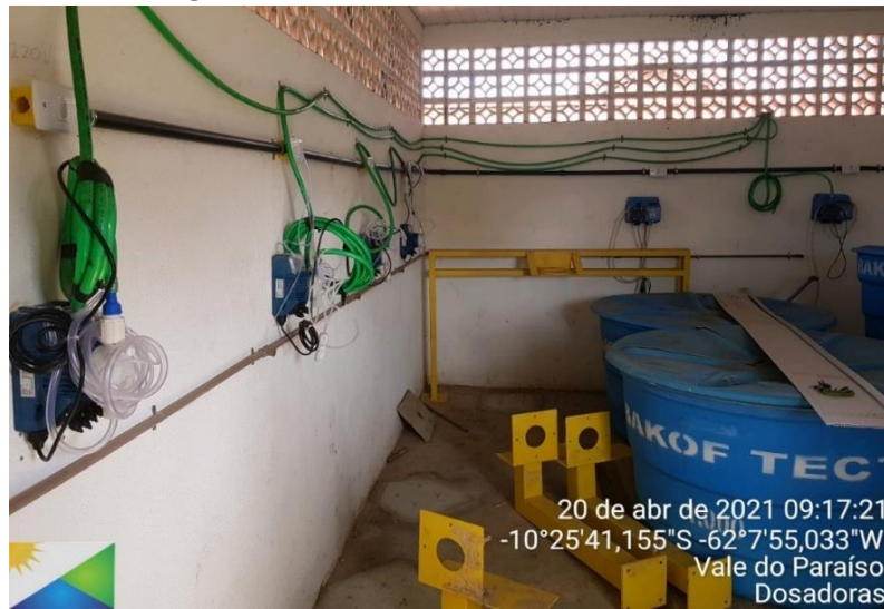
Figura 81 - Vista interna da Casa de Química
