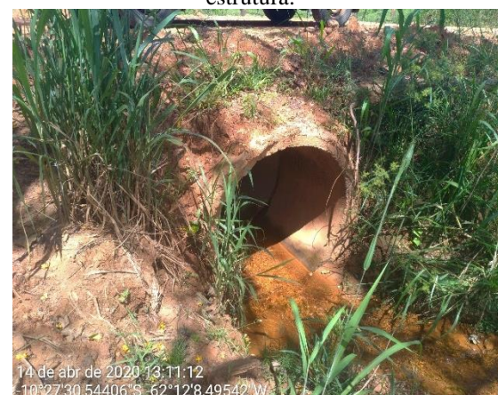
P 019 Tudo de Concreto (Linha 62) Estado de conservação: apresenta bom estado de conservação, bordas sem sinais de desgaste, ausência de erosão no entorno, sem sinais de
