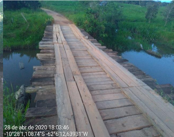
P 044 - Ponte de madeira linha 201 sentido linha 153.
