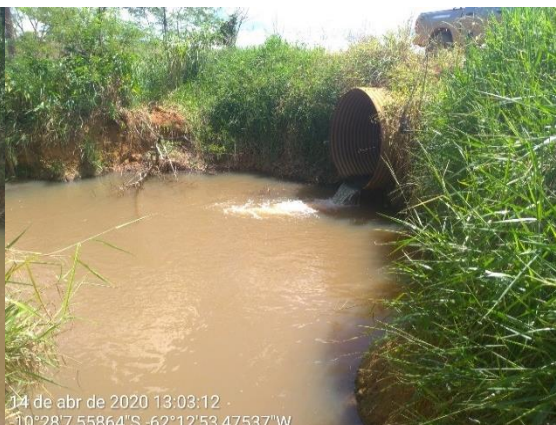
P 016 - Tubo Arco (Linha 62) Estado de conservação: Apresenta bom estado de conservação, com nenhum sinal de oxidação, fendas, buracos ou demais desgastes em sua estrutura.
