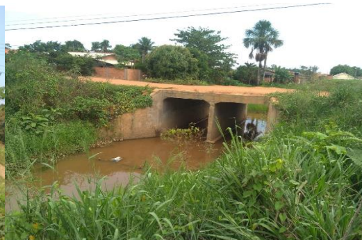
Fundo de Vale 2 - Rua Treze de Fevereiro – SETOR 4 10^{\circ}25'44.85''S e 62^{\circ}7'36.51''W Galeria de concreto armado Bom estado de conservação
