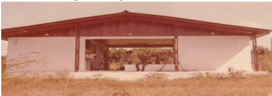
Figura 4 - Construção da Unidade Básica de Saúde
