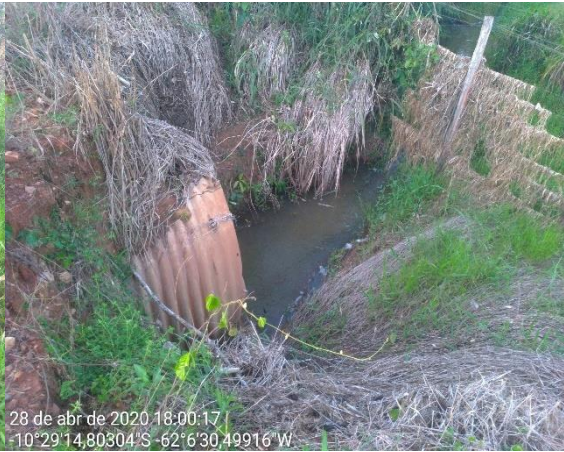
P 052 - Tubo Armco linha 201 sentido linha 153.
