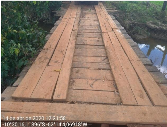
P 05 - Ponte de Madeira, (Travessão do Cristiano Linha 62)
