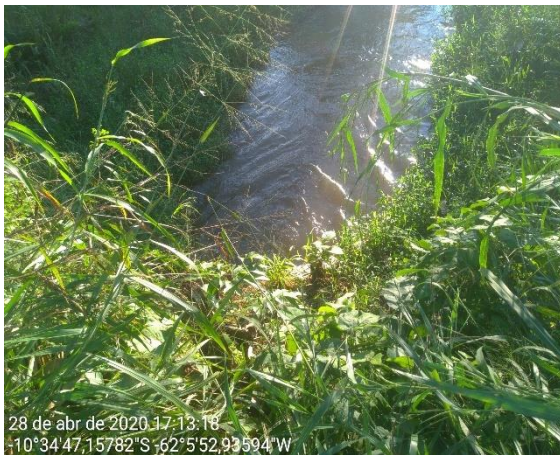
033 - Tubo de concreto linha 202 - sentido linha 153.
