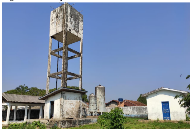
Figura 38 - Estação de Tratamento de Vale do Paraíso
