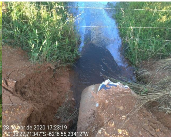
P 036- Tubo de concreto linha 202 - sentido linha 153.
