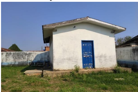
Figura 80 - Casa de química do SAA de Vale do Paraíso
