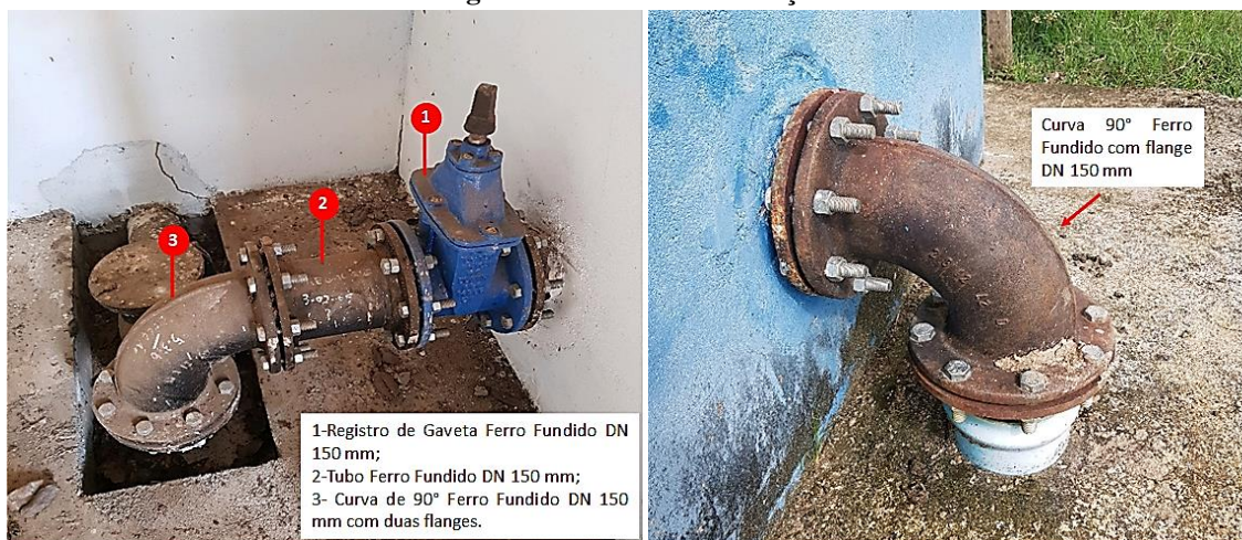
Figura 64 - Barrilete de sucção
