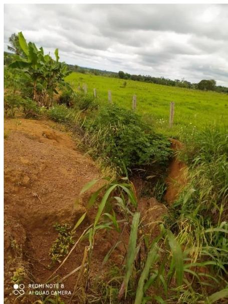
Lançamento final das águas pluviais nas proximidades do Igarapé Tres de Novembro com presença de erosões
