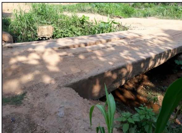
Ponte 2 - Ponte de Madeira. Coordenadas: 11°55'27.24"S e 61°59'44.10"O.
