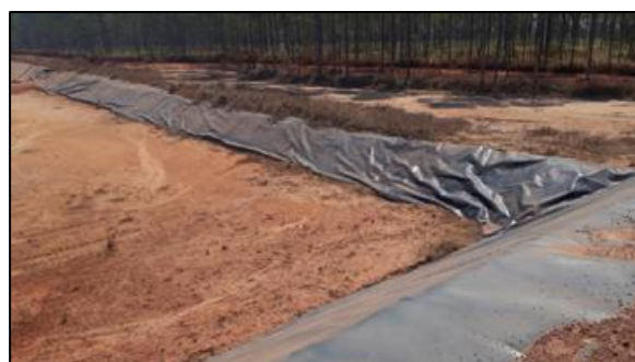
Sistema de Impermeabilização das Células
