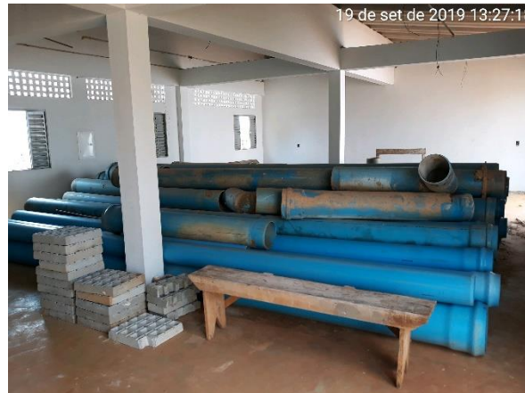
Interior do prédio que está servindo como depósito de tubulações
