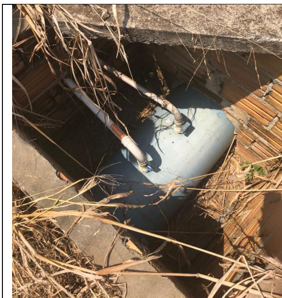
Desinfecção - Adição de Hipoclorito de Sódio na tubulação de entrada do reservatório apoiado
