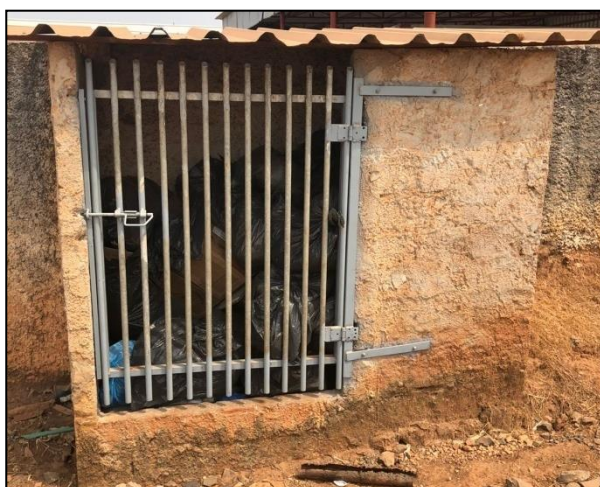
Acondicionamento dos resíduos com características domésticas do frigorífico.
