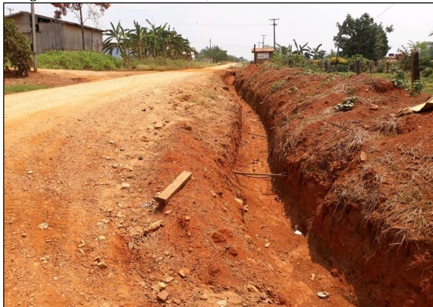
SA V1 – Vala na Av. Linha 65.
