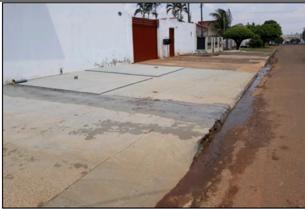
Água de limpeza despejada em via pública. Coordenadas: 11°55'32.97"S; 61°59'25.30"O.
