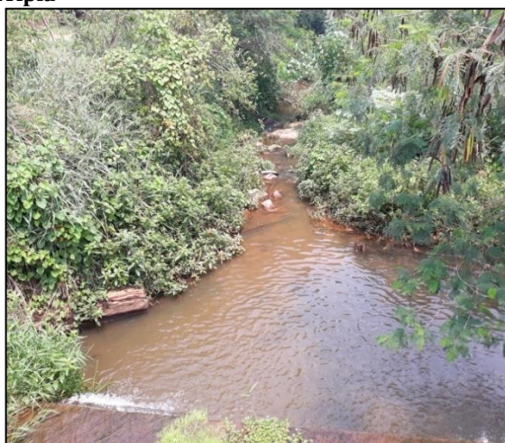
G7 - Galeria de concreto. Coordenadas: 11°56'1.24"S e 61°59'37.41"O.
