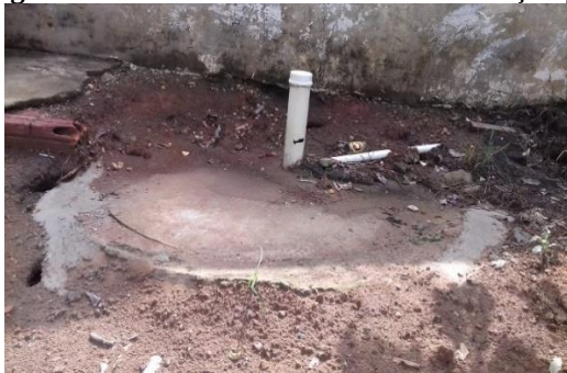
Figura 158 - Fossas rudimentares em situação precária na sede do município de Alta Floresta D'Oeste
