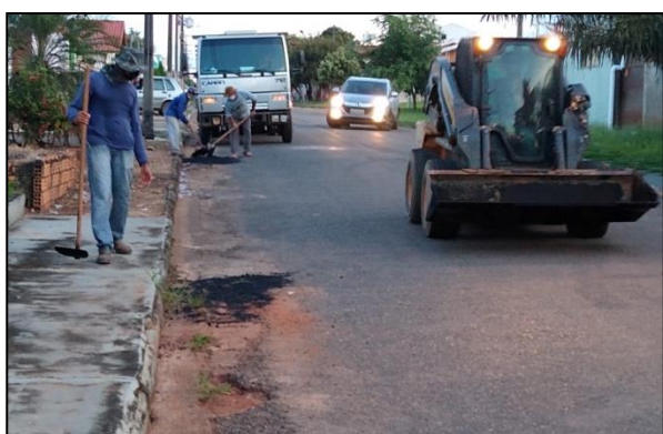
Manutenção de via, na área urbana de Alta Floresta D'Oeste.
