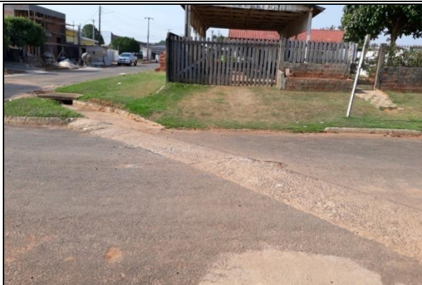
Dispositivo mal projetado. Coordenadas: 11°55'38.34"S; 61°59'7.49"O.
