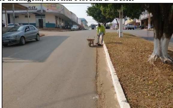
Limpeza de sarjeta, na área urbana de Alta Floresta D'Oeste.
