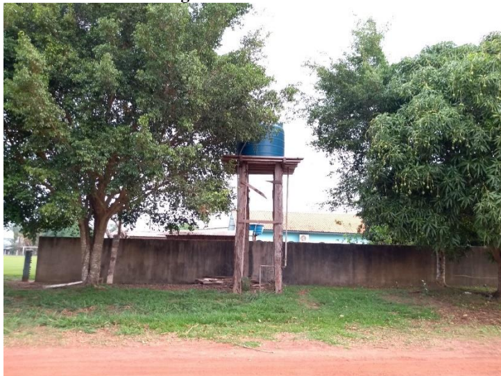
Figura 11- Reservatório d'água localizada no Distrito de Filadélfia d'Oeste
