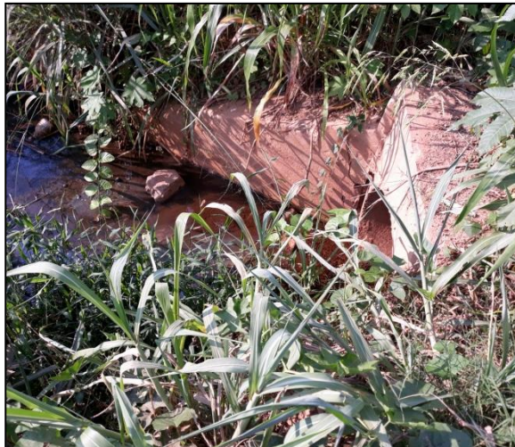
L6 - Lançamento de águas pluviais. Coordenadas: 11°55'24.52"S e 61°59'43.96"O.
