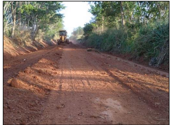
Manutenção de estrada, na área rural de Alta Floresta D'Oeste.
