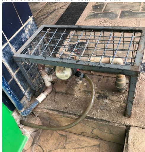
Figura 111 - Ligações com e sem hidrômetros da sede de Alta Floresta D' Oeste
