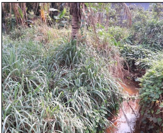
G4 - Galeria de concreto. Coordenadas: 11°56'0.39"S e 61°59'28.76"O.
