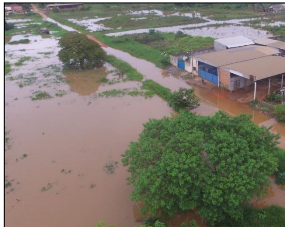
Alagamento na Av. Amazonas.
