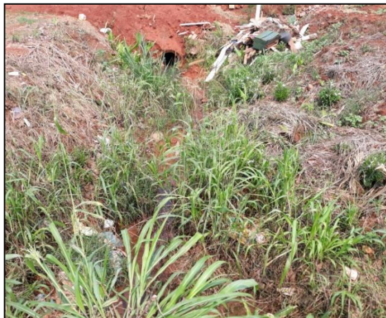
G6 - Galeria de concreto. Coordenadas: 11°55'50.50"S e 61°59'26.90"O.
