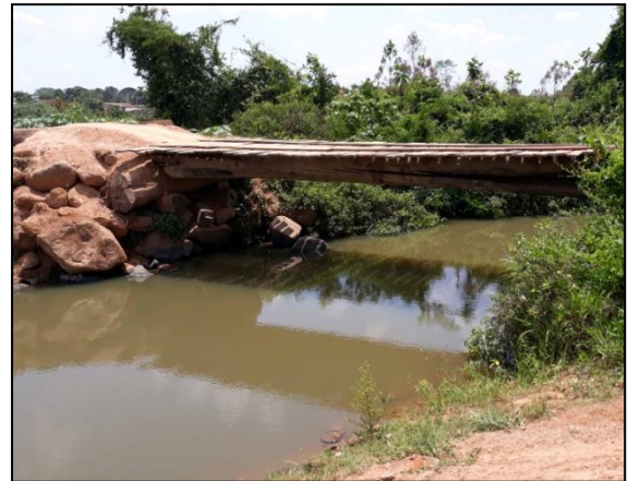
P1 - Ponte de Madeira. Coordenadas: 11°55'31.03"S e 61°59'55.61"O.
