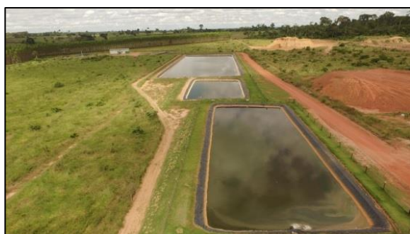
Estação de Tratamento de Efluentes - ETE
