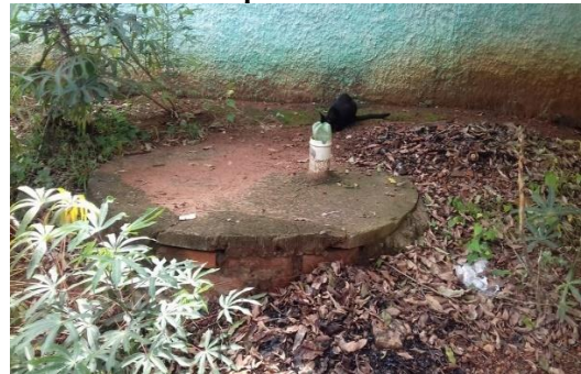
Figura 158 - Fossas rudimentares em situação precária na sede do município de Alta Floresta D'Oeste
