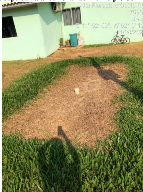
Figura 167 – Fossa séptica na área rural do município de Alta Floresta D'Oeste
