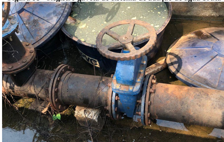
Figura 95 - Registro gaveta do sistema de adução de água bruta
