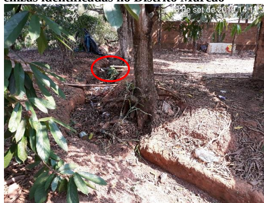
Tubulação de lançamento de águas cinzas em vala Coordenadas: 12°7'57.46''S e 61°59'34.24''O
