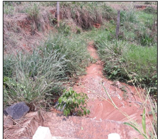
L15 - Lançamento de águas pluviais. Coordenadas: 11°56'16.37"S e 61°59'37.36"O.
