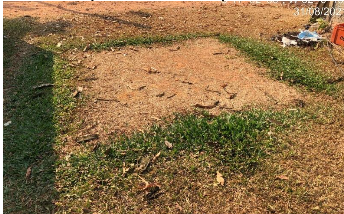
Figura 157 – Fossa séptica na sede do município de Alta Floresta D'Oeste
