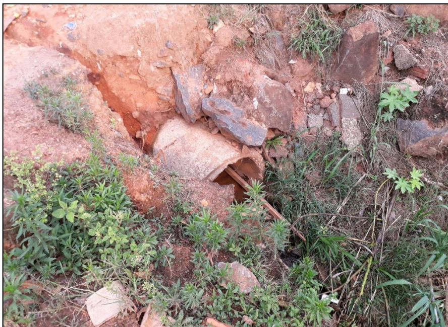
L19 - Lançamento de águas pluviais. Coordenadas: 11°55'59.66"S e 62°0'26.85"O.
