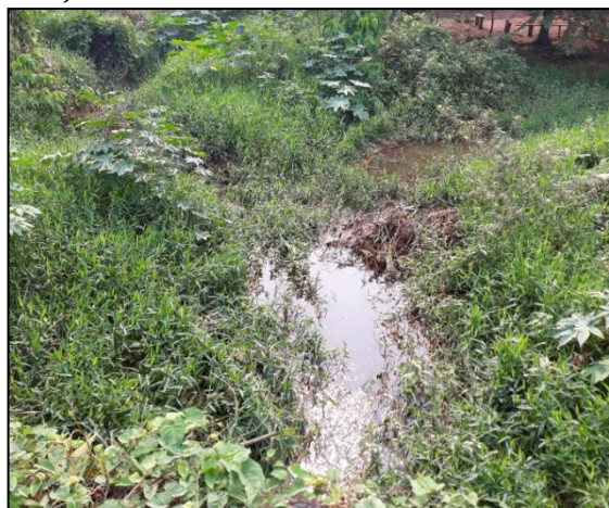
G3 - Galeria de concreto. Coordenadas: 11°59'0.19"S e 61°59'30.66"O.
