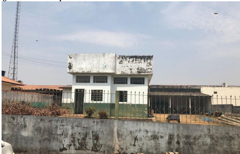
Figura 83 - Sede de apoio administrativo do SAAE da sede de Alta Floresta D' Oeste
