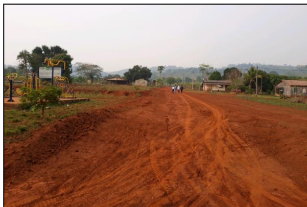
Distrito de Nova Gease D'Oeste. Coordenadas: 11°55'4.91"S e 62°19'6.63"O.
