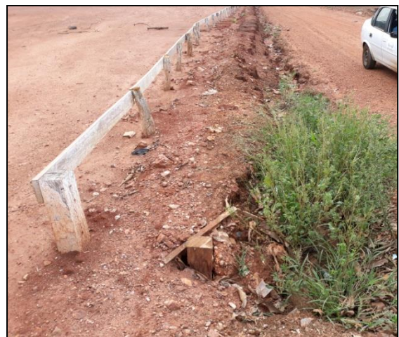
L17 - Lançamento de águas pluviais em vala. Coordenadas: 11°56'14.85"S e 62°0'14.04"O.
