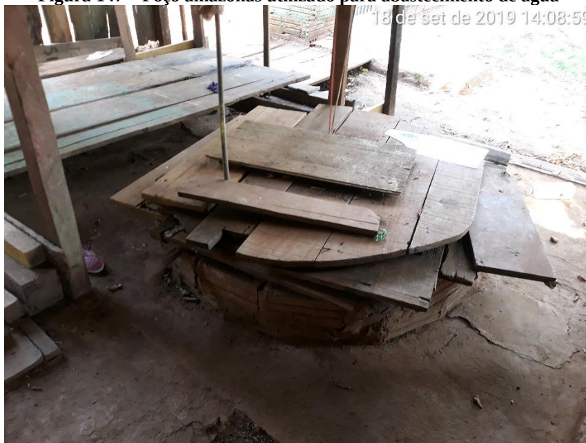
Figura 147 – Poço amazonas utilizado para abastecimento de água
