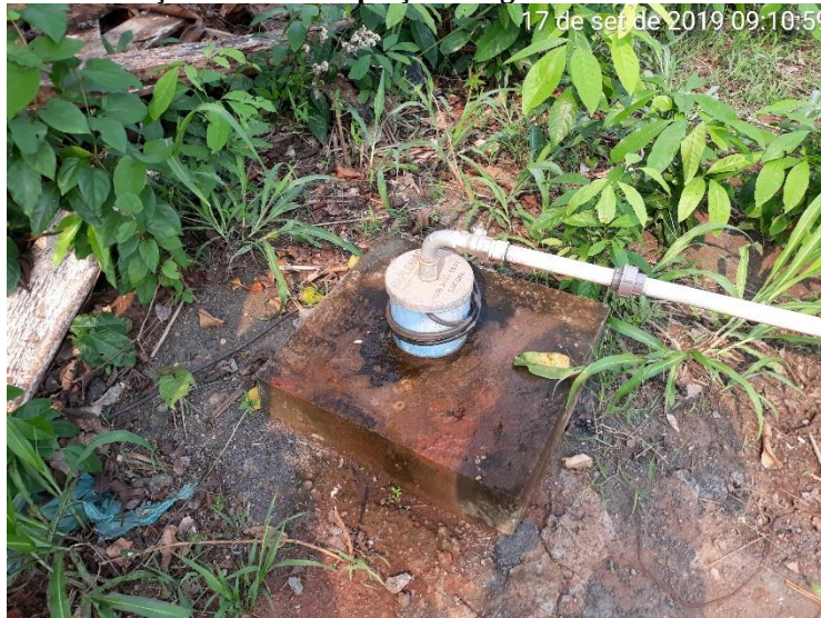
Figura 114 – Poço tubular de captação de água do Distrito Nova Gease
