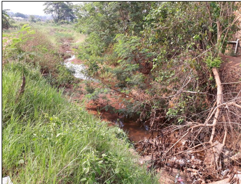
L16 - Lançamento de águas pluviais. Coordenadas: 11°55'44.86"S e 62°0'0.61"O.
