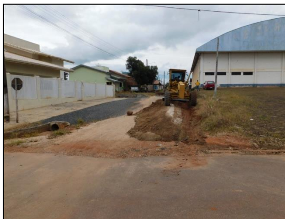
Manutenção de via, na área urbana de Alta Floresta D'Oeste.
