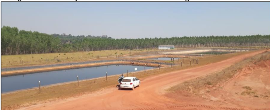
Figura 239 - Lagoas de estabilização utilizadas no tratamento biológico de lixiviados do aterro sanitário.
