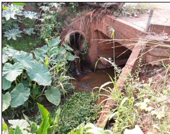
G2 - Galeria de concreto. Coordenadas: 11°55'56.95"S e 61°59'30.67"O.
