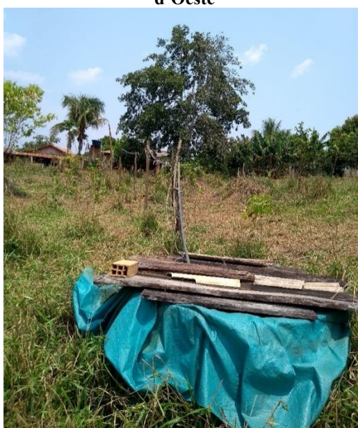
Figura 65 – Abastecimento de água da residência através de poço amazônico – Distrito de Santo Antônio d'Oeste
