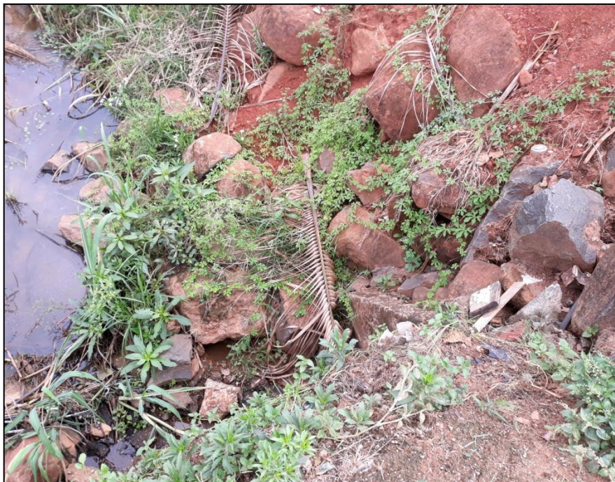
L18 - Lançamento de águas pluviais. Coordenadas: 11°55'59.61"S e 62°0'27.01"O.
