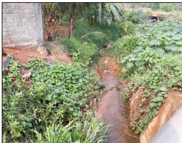
G4 - Galeria de concreto. Coordenadas: 11°55'58.29"S e 61°59'30.09"O.
