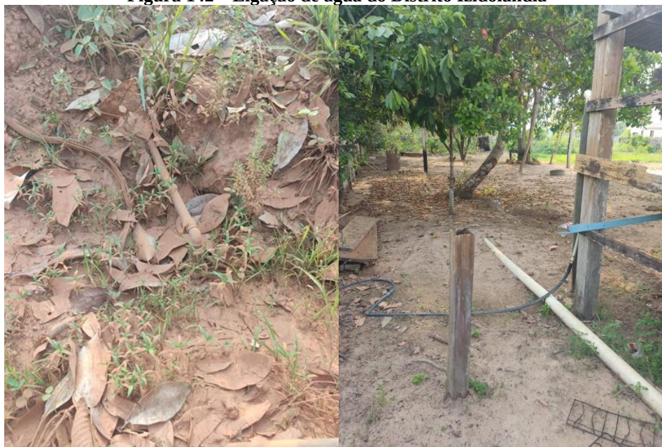
Figura 142 – Ligação de água do Distrito Izidolândia
