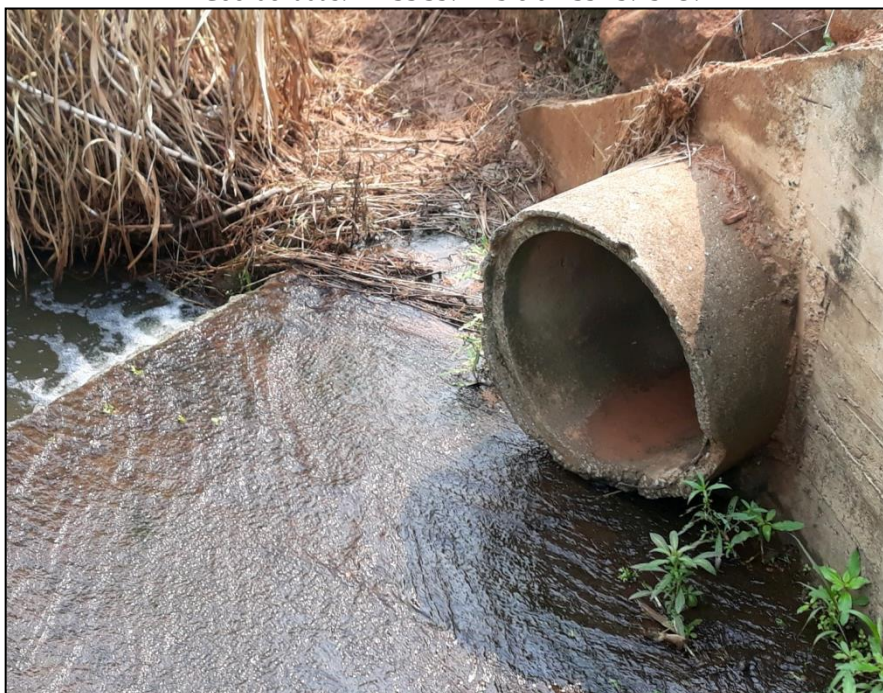
L12 - Lançamento de águas pluviais. Coordenadas: 11°56'2.33"S e 61°59'29.29"O.
