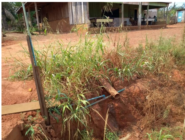
Figura 37- Canalização das águas residuais para a marginal da estrada – Distrito Marcão
