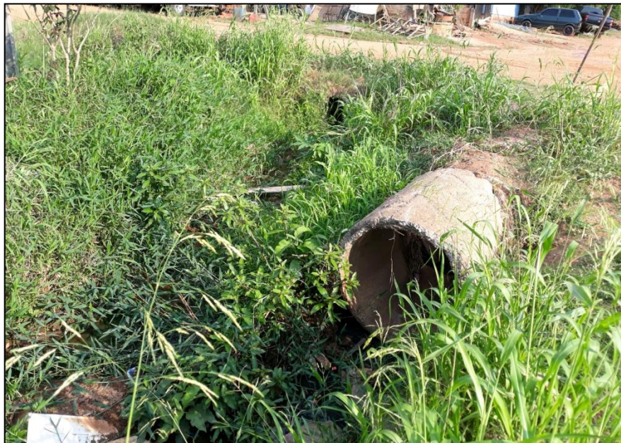
L7 - Lançamento de águas pluviais. Coordenadas: 11°55'33.02"S e 61°59'48.11"O.
