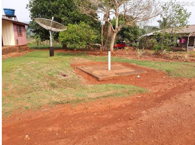
Figura 160 – Fossa rudimentar instalada no Distrito Nova Gease
