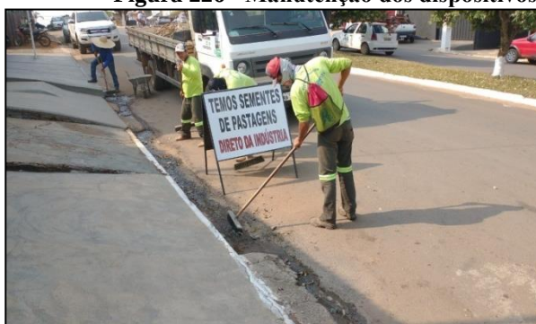
Limpeza de sarjeta e boca de lobo, na área urbana de Alta Floresta D'Oeste.
