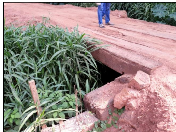
Ponte 3 - Ponte de Madeira. Coordenadas: 11°55'25.94"S e 61°59'43.91"O.
