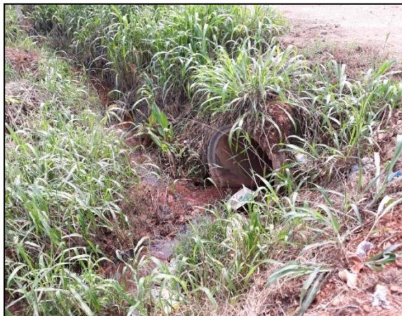
G6 - Galeria de concreto. Coordenadas: 11°55'50.55"S e 61°59'27.12"O.
