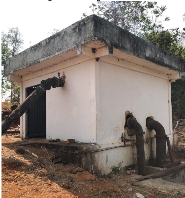
Figura 90 - Abrigo de alvenaria
