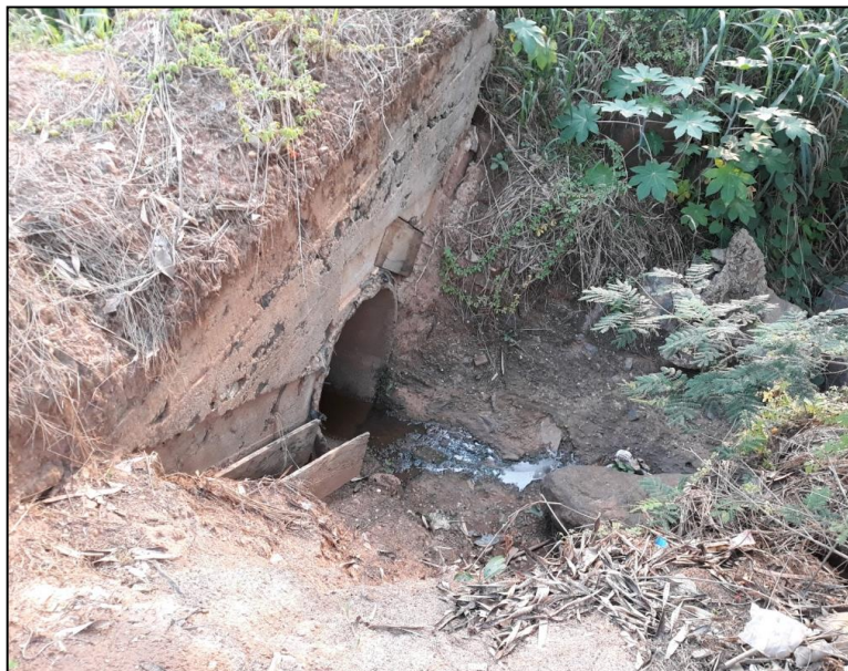
L21 - Lançamento de águas pluviais. Coordenadas: 11°55'47.10"S e 62°0'12.92"O. Fonte: Projeto Saber Viver (2021), IFRO/FUNASA (TED 08/2017).
