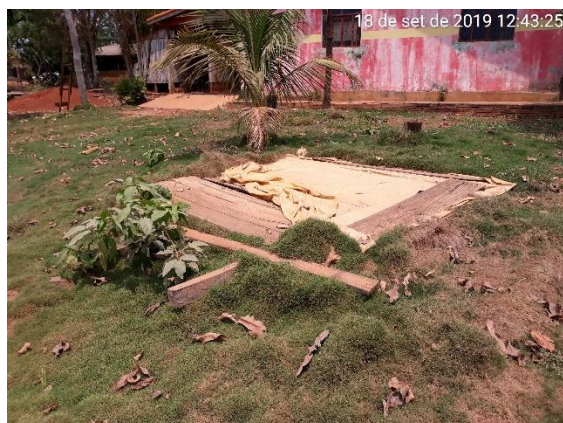
Fossa Rudimentar do Distrito Marcão
