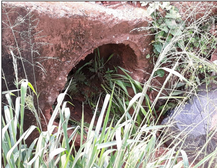
L11 - Lançamento de águas pluviais. Coordenadas: 11°55'59.71"S e 61°59'29.49"O.
