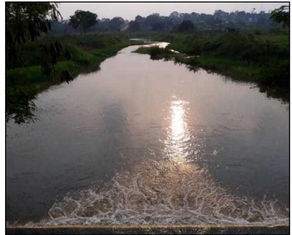
G8 - Galeria de concreto. Coordenadas: 11°55'44.64"S e 62°0'13.85"O.
