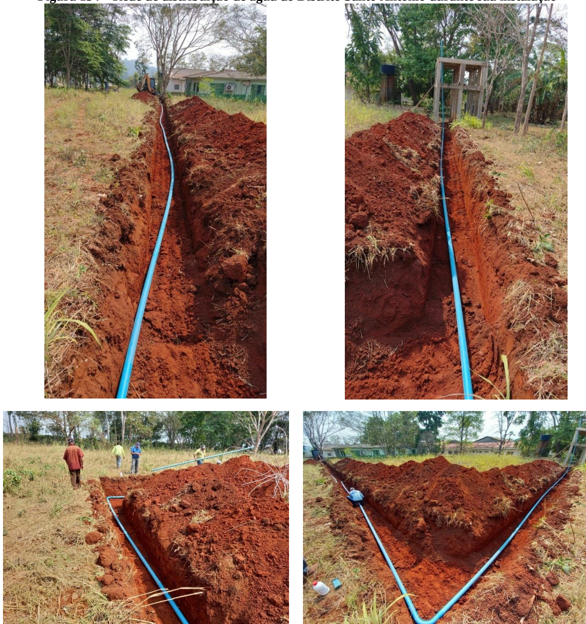
Figura 134 – Rede de distribuição de água do Distrito Santo Antônio durante sua instalação
