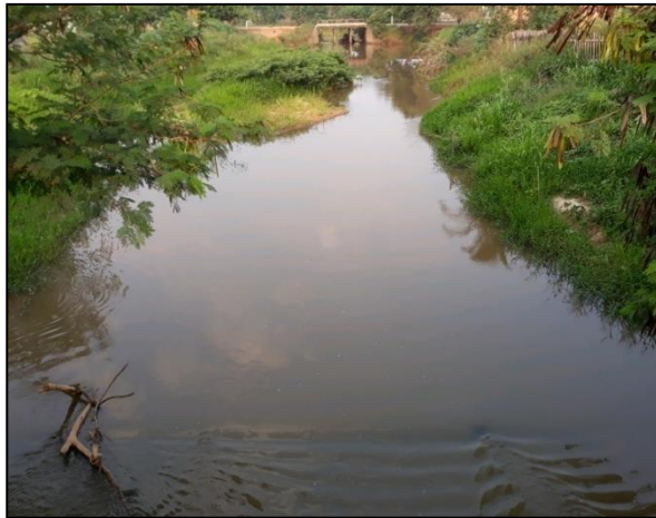
G8 - Galeria de concreto. Coordenadas: 11°55'44.45"S e 62°0'13.60"O.
