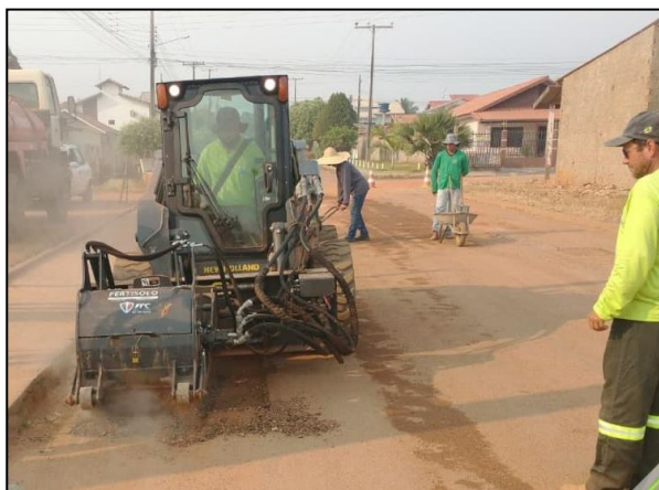
Manutenção de via, na área urbana de Alta Floresta D'Oeste.
