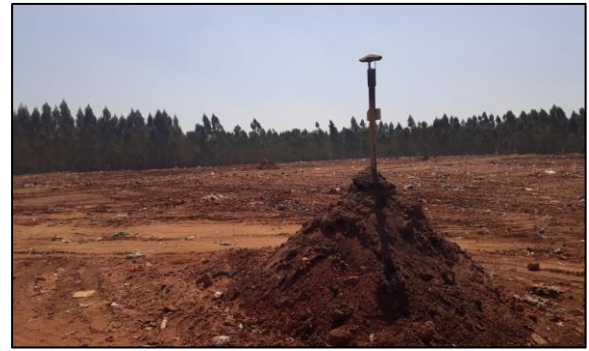
Sistema de Drenagem de Gás e de Líquido Percolado (chorume)
