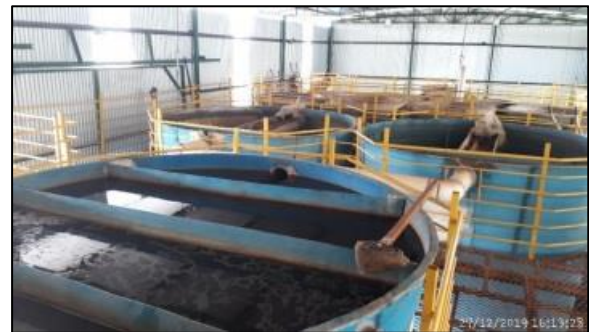
Estação de Tratamento de Efluentes - ETE
