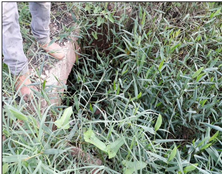
L20 - Lançamento de águas pluviais. Coordenadas: 11°55'50.81"S e 62°0'21.53"O.
