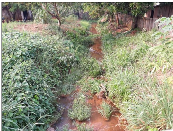
G2 - Galeria de concreto. Coordenadas: 11°55'56.82"S e 61°59'28.64"O.
