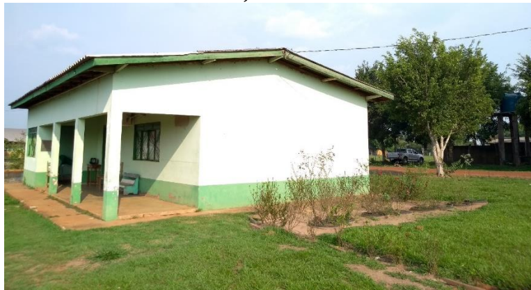
Figura 52 - Unidade Básica de Saúde, localizada no Distrito de Filadélfia d'Oeste
