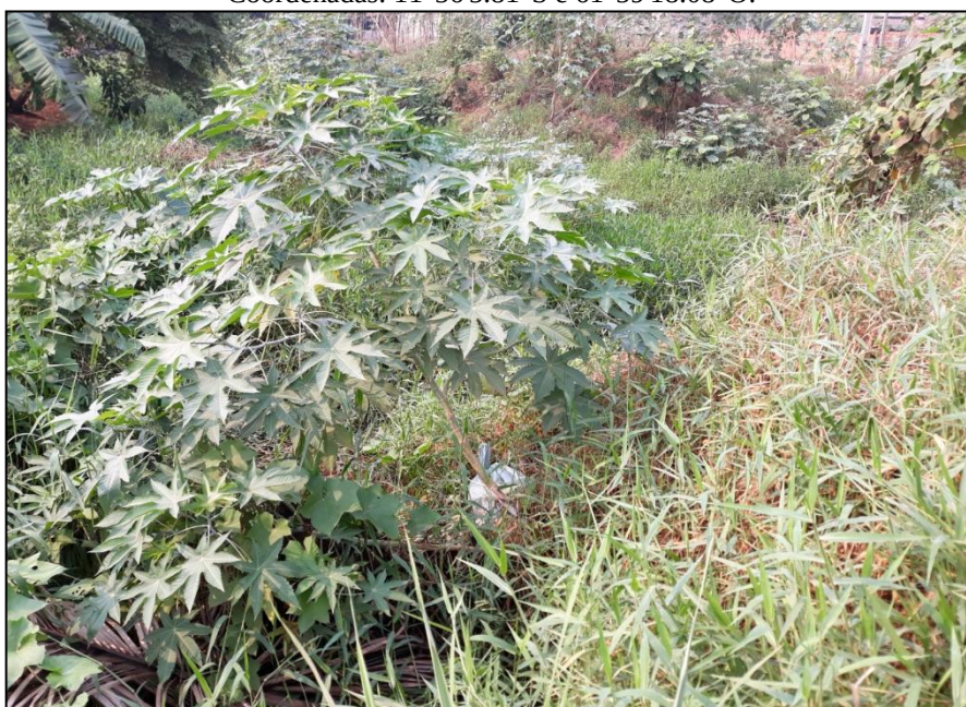
L10 - Lançamento de águas pluviais. Coordenadas: 11°55'58.41"S e 61°59'30.43"O.
