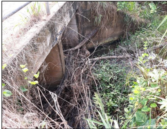
G5 - Galeria de concreto. Coordenadas: 11°56'2.55"S e 61°59'29.41"O.
