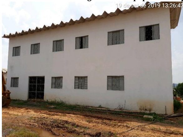
Prédio onde seria o laboratório e a casa de química da ETA
