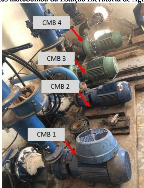
Figura 109 - Conjuntos motobomba da Estação Elevatória de Água Tratada da sede
