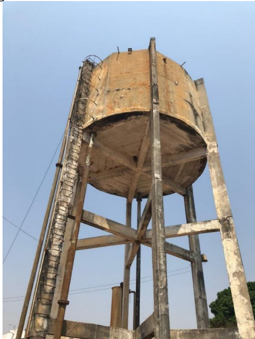
Figura 103 - Reservatório Elevado de distribuição
