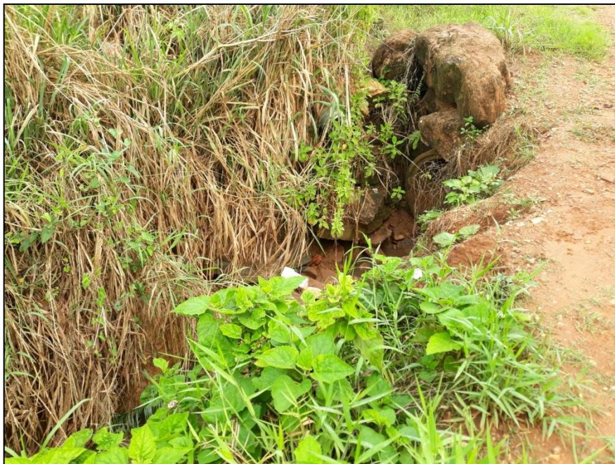
L8 - Lançamento de águas pluviais. Coordenadas: 11°56'5.81"S e 61°59'18.08"O.
