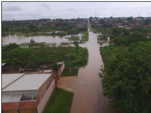
Alagamento na Av. São Paulo.
