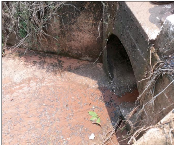
L15 - Lançamento de águas pluviais. Coordenadas: 11°56'16.31"S e 61°59'37.30"O.
