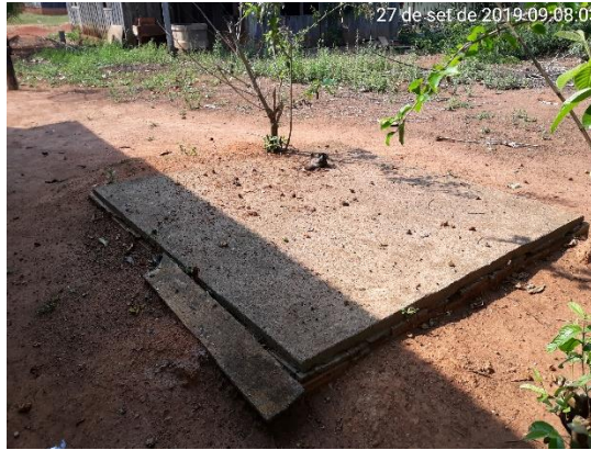
Figura 163 – Fossa rudimentar instalada no Distrito Izidolândia
