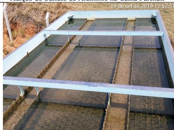
Decantador com calhas
