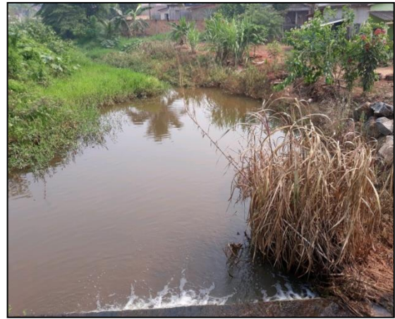
G5 - Galeria de concreto. Coordenadas: 11°56'2.43"S e 61°59'29.28"O.
