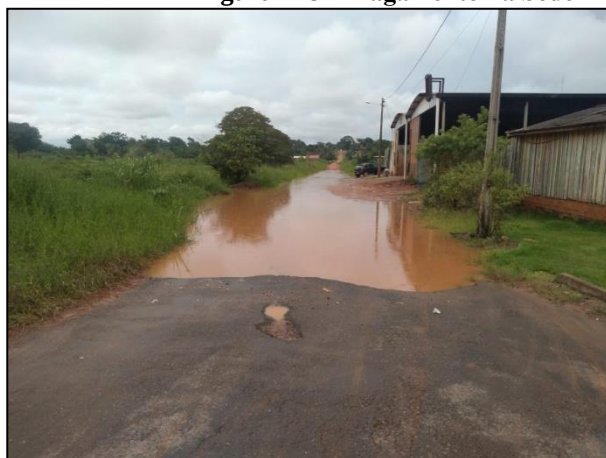
Alagamento na Av. Amazonas.
