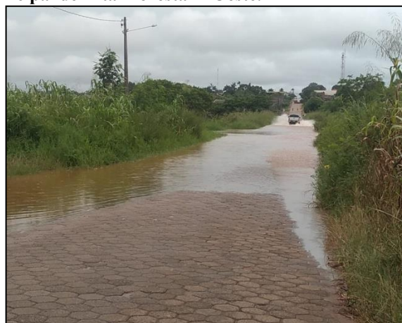
Alagamento na Av. São Paulo.
