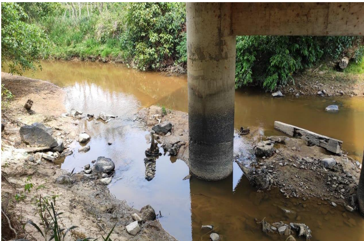
Figura 4— Vista do Igarapé Isidro
