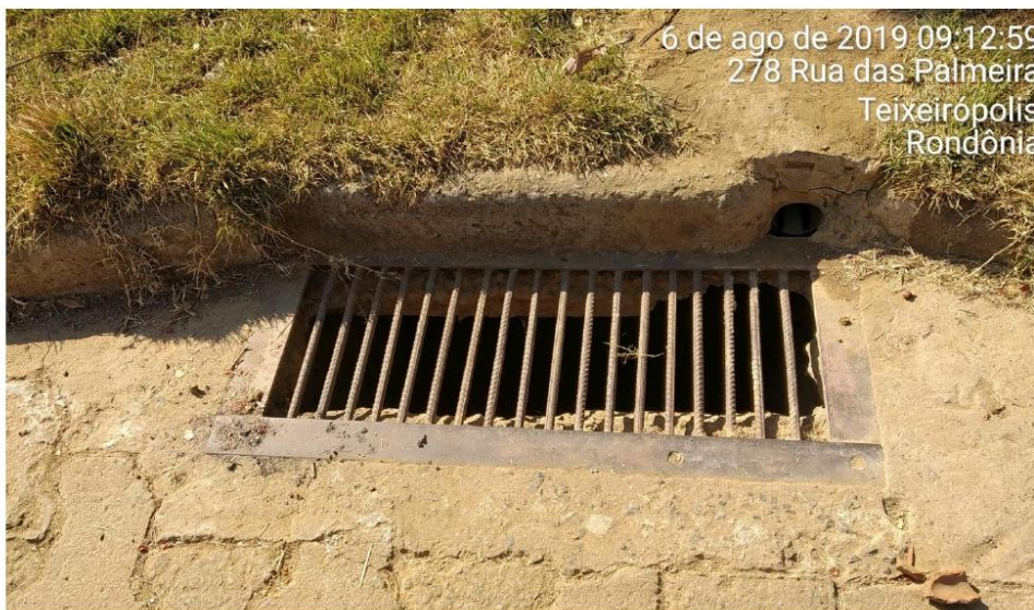
Figura 14. Registro das bocas de lobos existentes.
