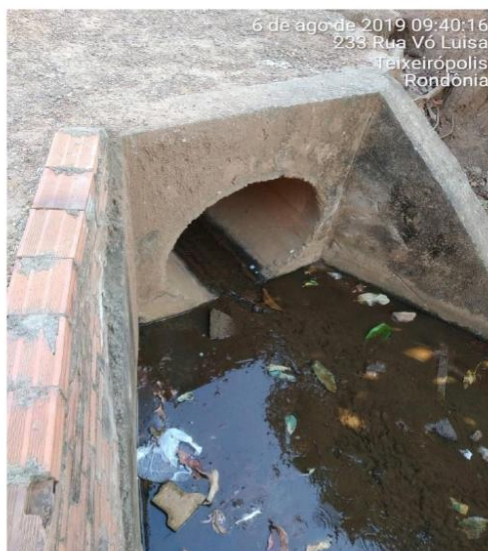
Figura 15. Registro de drenagens existentes.
