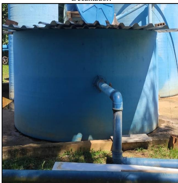
Tanque Clorador.
