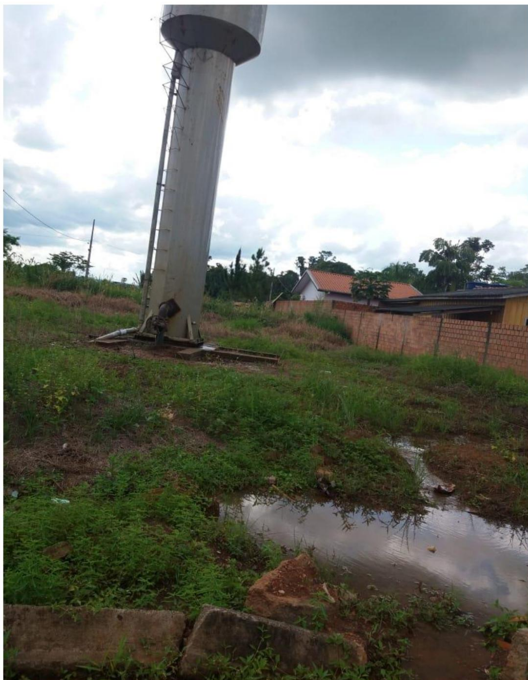
Reservatório Elevado que distribui água para as residências
