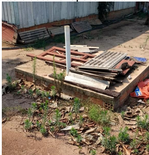
Fossa rudimentar na Linha 40 na zona rural
