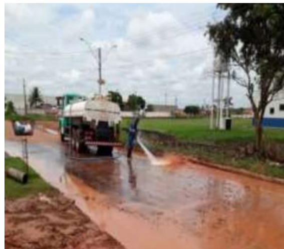
Figura 40— Limpeza do local pós manutenção da adutora na R. Raposo Tavares.
