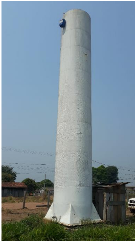
Figura 57— Reservatório Elevado do Distrito Urucumacua.
