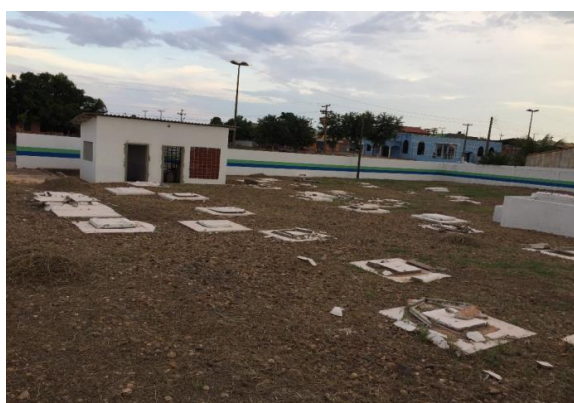
Figura 75— Vista da casa de química e dos filtros anaeróbios.
