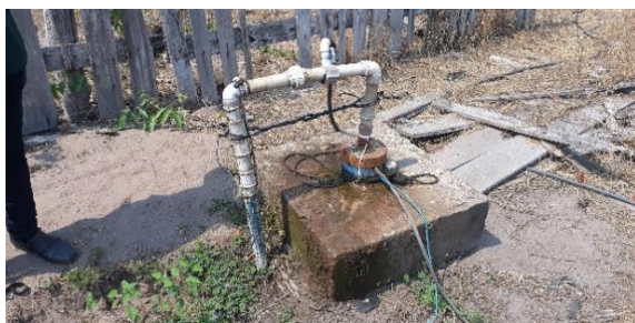
Figura 52— Vista do poço tubular 02.
