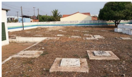
Figura 74— Vista das caixas de inspeções da ETE Sub-bacia B.
