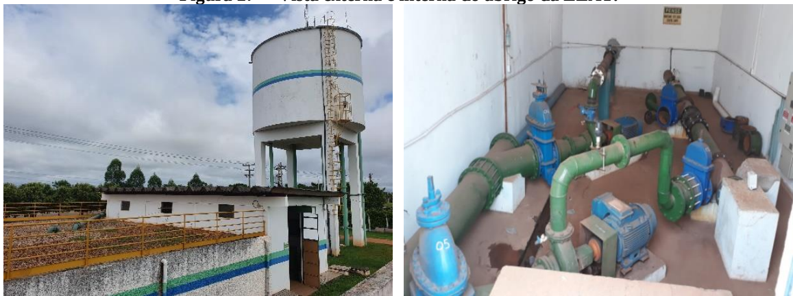
Figura 27— Vista externa e interna do abrigo da EEAT.
