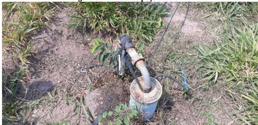
Figura 50— Vista do poço tubular 01
