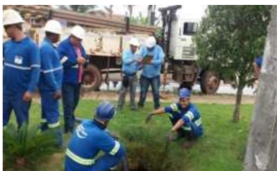
Figura 37— Reparo na adutora de água tratada PVC DN 150 mm BR-364.
