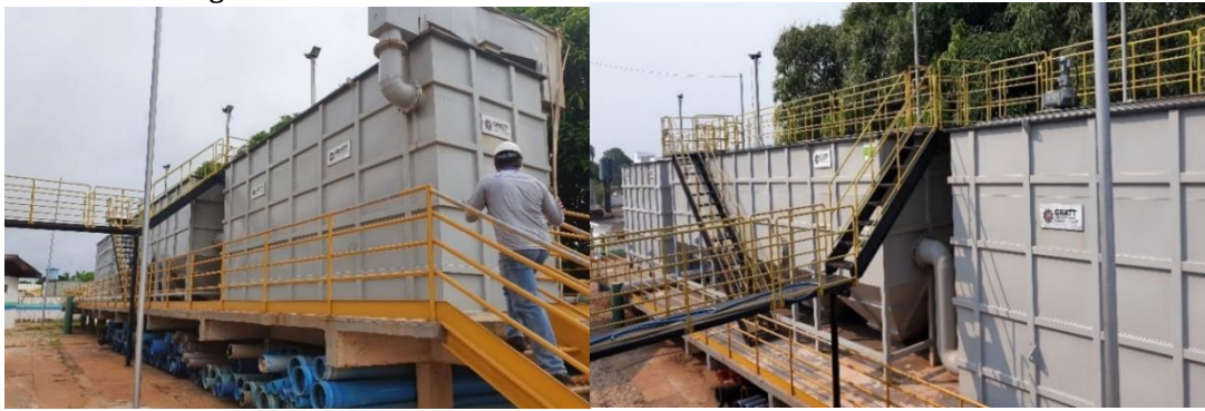
Figura 21— ETA Convencional Modular Gratt de Pimenta Bueno.
