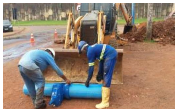
Figura 38— Substituição de registro DN 300 mm na adutora de água tratada PVC PBA DN 300 mm na Av. Marechal Rondon.
