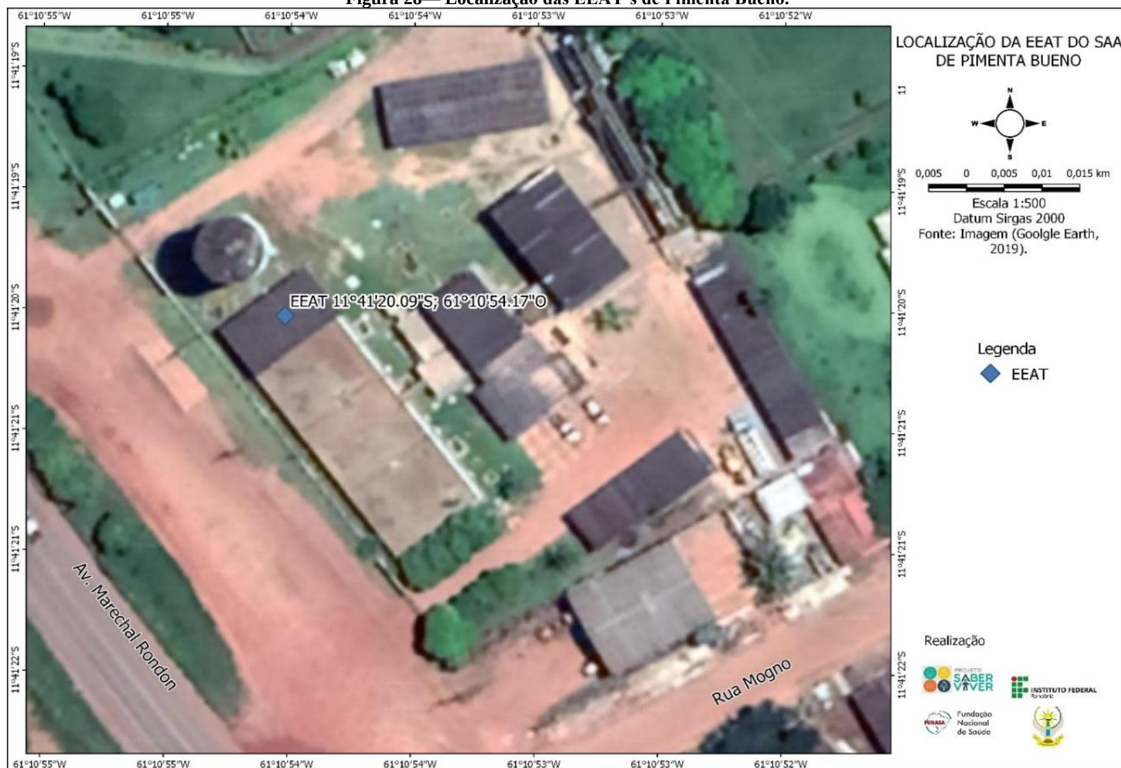
Figura 28— Localização das EEAT's de Pimenta Bueno.
