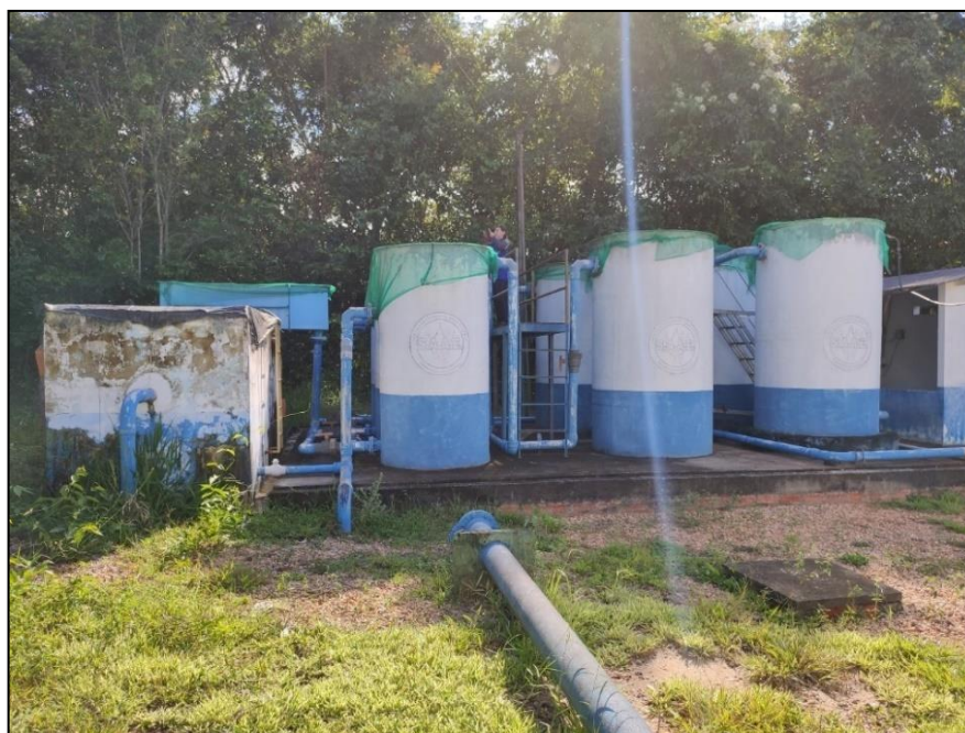
Figura 14 – Vista da Estação de Tratamento de Água da sede
