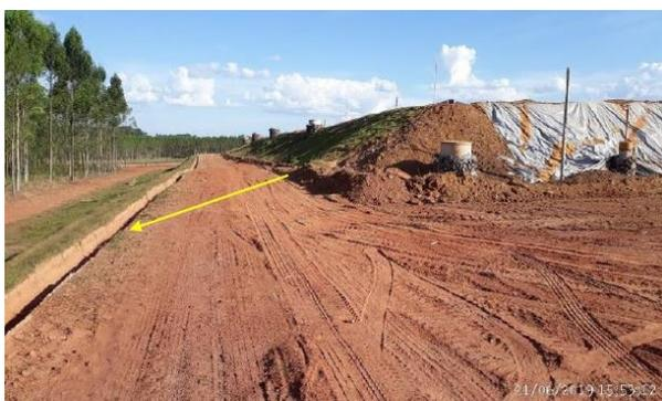
Sistema de drenagem de águas superficiais
