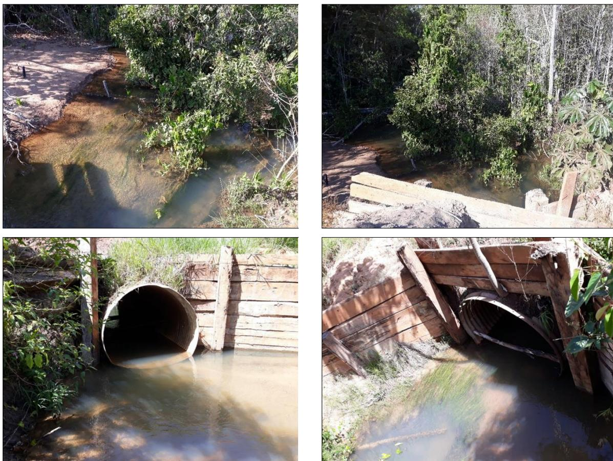
Bueiro de tubo de chapas de aço corrugadas e aparafusadas
