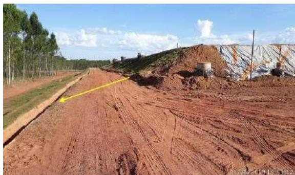
Sistema de drenagem de águas superficiais
