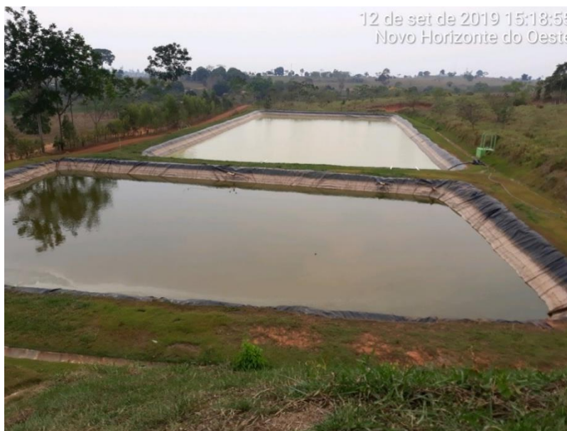
Figura 27 - Lagoas de Estabilização.
