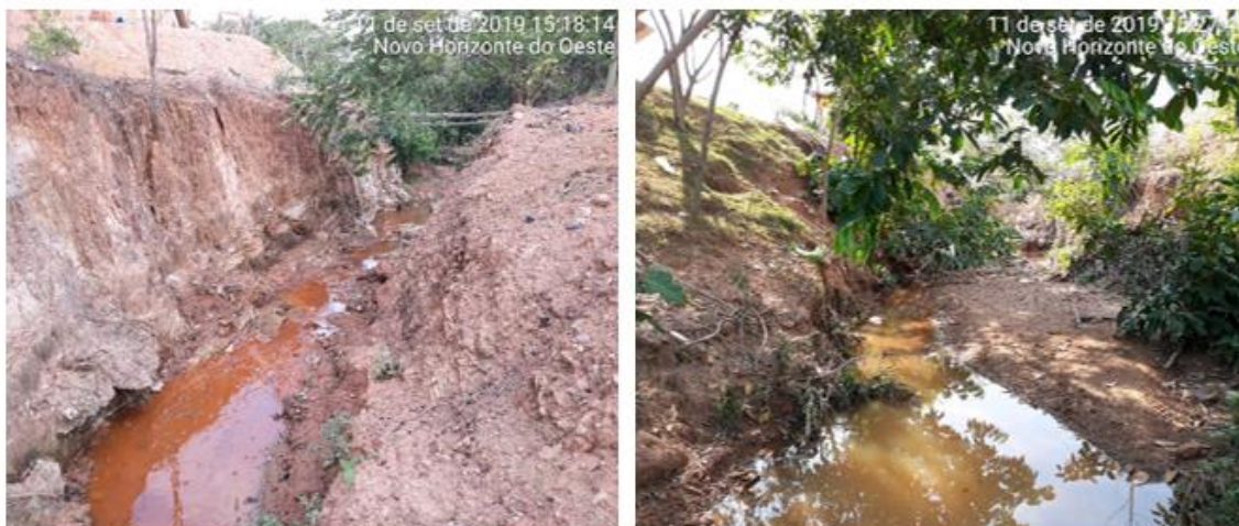
Figura 28 – Canal natural - principal receptor das águas da microdrenagem da sede
