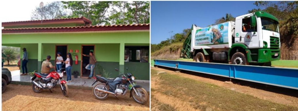
Figura 24 – Esquerda: Escritório administrativo. Direita: Balança rodoviária para pesagem de RSU.
