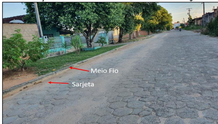
Figura 27—Pavimentação em Blocos Sextavados com Meio-Fio e Sarjeta na Rua Paraná.
