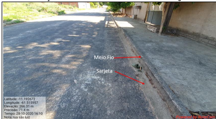
Figura 26—Pavimentação em TSD-Asfalto com Meio-Fio e Sarjeta na Rua São Luis.
