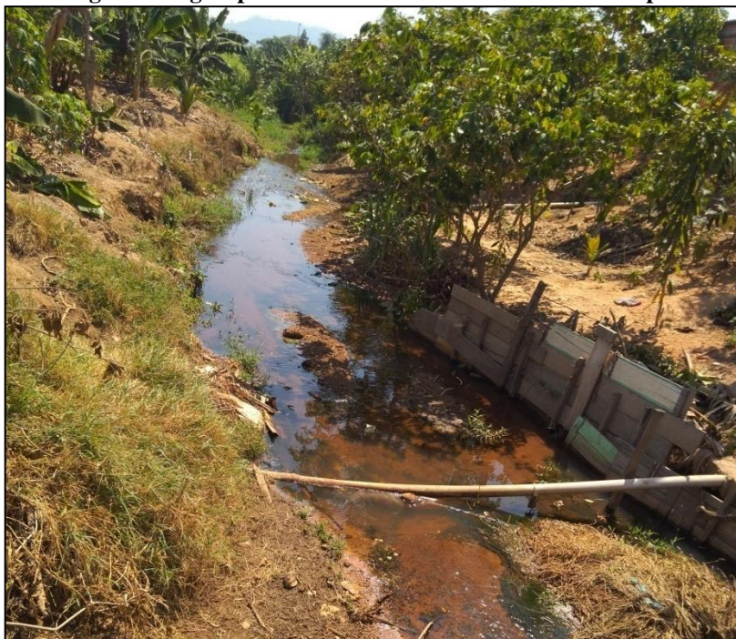
Figura 8—Igarapé ao Nordeste da Área Urbana Municipal
