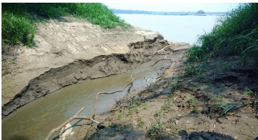
Figura 26 - Ausência de Área de Preservação Permanente no entorno do Igarapé sem nome desaguando no Rio Mamoré – Coordenadas geográfica: 10°35'21.80"S e 65°23'15.19"O
