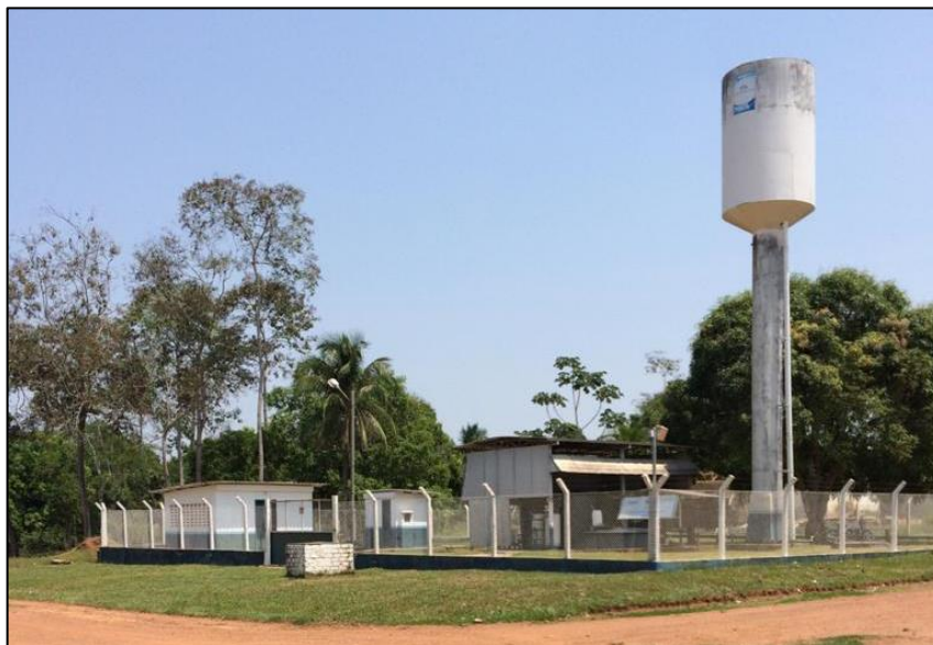
Figura 18—Infraestruturas do Sistema de Abastecimento de Água do Distrito de Iata.
