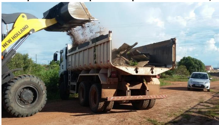
Figura 4— Campanha Cidade Limpa realizada pela SEMOSP na remoção de RCC.
