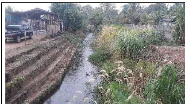
Rua Humaitá - Canal retificado 1 lateral com pedra Coordenadas:13°07'31.99"S e 60°32'31.70"W
