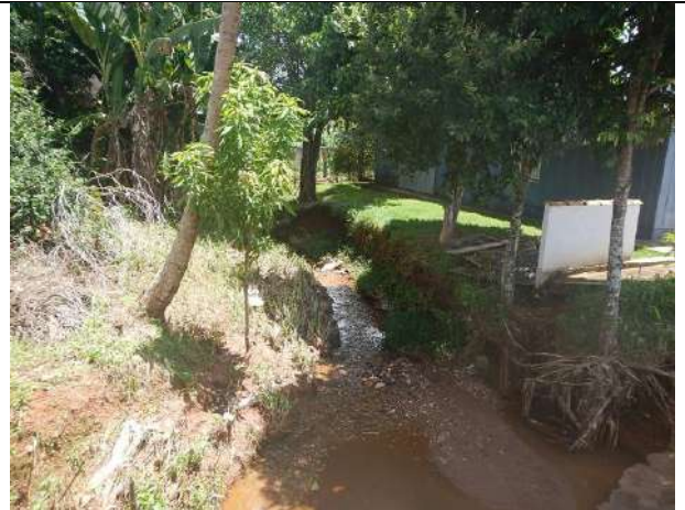
Moradia instalada na área de planície de inundação Fonte: CPRM (2016)
