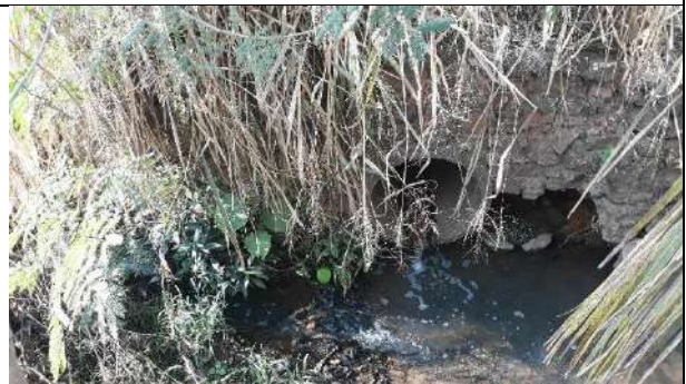
Rua Cabixi - 3 manilhas de 0,8m de diâmetro Coordenadas: 13°07'08.48"S e 60°33'00.84"W
