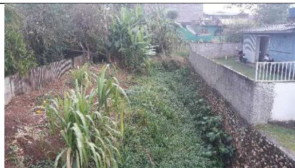
Rua Humaitá – Canal retificado Coordenadas: 13°07'45.89"S e 61°32'30.00"W
