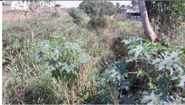
Rua Rio Grande do Sul – bueiro, manilha de 0,8m de diâmetro Coordenadas: 13°06'57.62"S e 60°32'36.48"W
