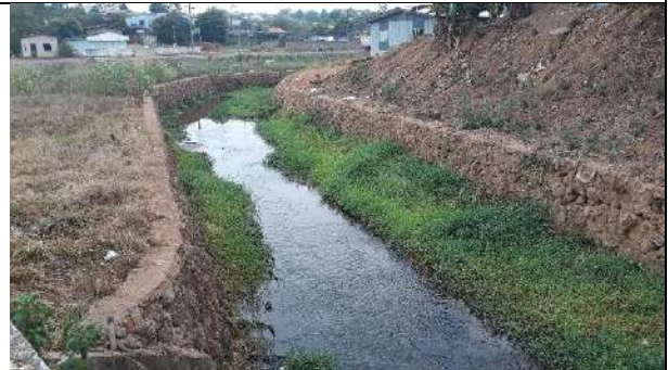
Rua Tupi - Canal retificado nas 2 laterais com pedra Coordenadas:13°07'31.49"S e 60°32'28.39"W
