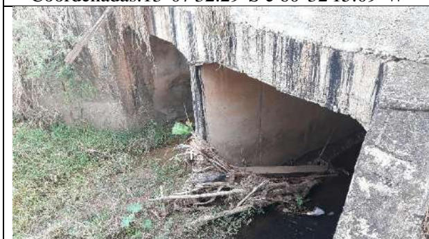
Rua Nu Aruaques – Galeria Dupla de 4m x 2m x 6m Coordenadas: 13°07'32.55"S e 60°32'18.66"W
