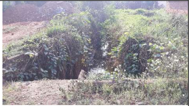
Rua Corumbiara - Canal Retificado com pedras Coordenadas: 13°07'07.24"S e 60°32'57.51"W
