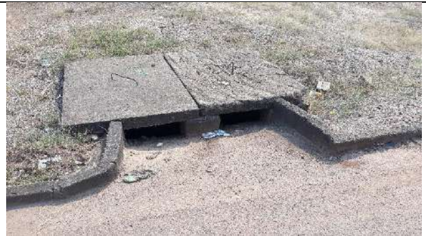
Boca de guia dupla em boas condições na Rua Tapinambá Coordenadas: 13° 7'20.39"S e 60°32'39.99"W
