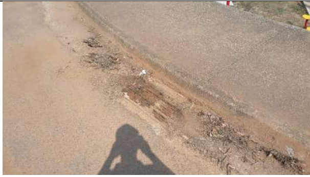
Boca de sarjeta em boas condições Coordenadas: 13° 7'19.67"S e 60°32'44.85"W
