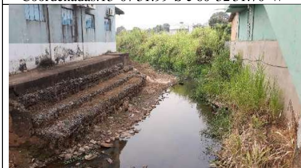
Rua Potguara - Canal retificado 1 lateral com pedra Coordenadas:13°07'34.96"S e 60°32'35.16"W
