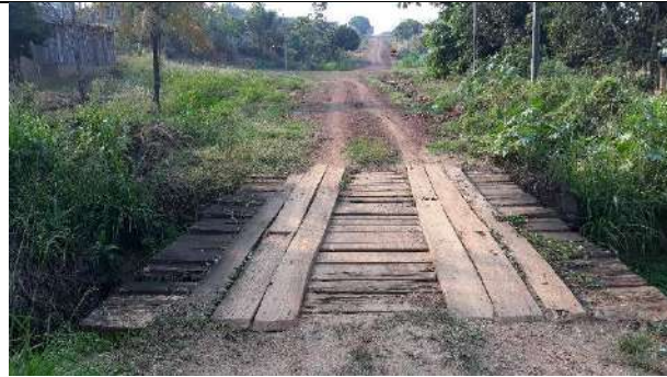
Rua Caetés – Ponte 4 m de extensão x 3m largura Coordenadas: 13°07'28.22"S e 61°32'09.25"W
