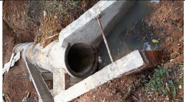
Bueiro de saída entre Rua Potguara e Rua Humaitá Coordenadas: 13° 7'32.27"S e 60°32'33.62"W
