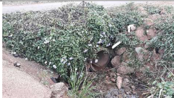
Av. Rio Negro – bueiro de travessia – 2 manilhas de 1m Coordenadas: 13°07'20.74"S e 61°32'23.74"W
