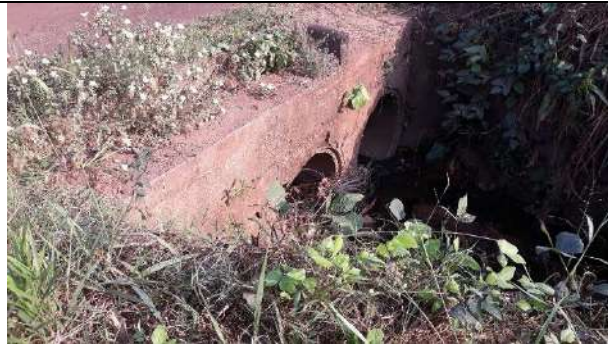
Rua Corumbiara - 3 manilhas de 1m de diâmetro Coordenadas: 13°07'07.24"S e 60°32'57.51"W
