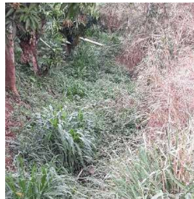
Figura 136 – Lançamento de esgoto doméstico identificado no ponto 5.
