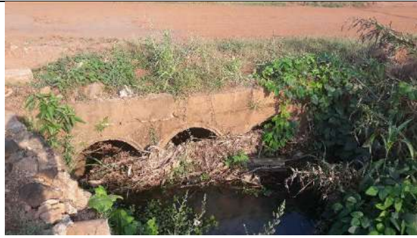
Rua dos Parecis - 4 manilhas de 1m de diâmetro Coordenadas: 13°07'06.63"S e 60°32'54.20"W
