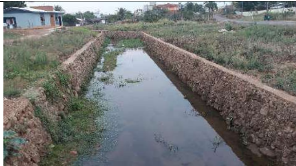
Rua Guarani - Canal retificado nas 2 laterais com pedra Coordenadas:13°07'29.17"S e 60°32'25.73"W
