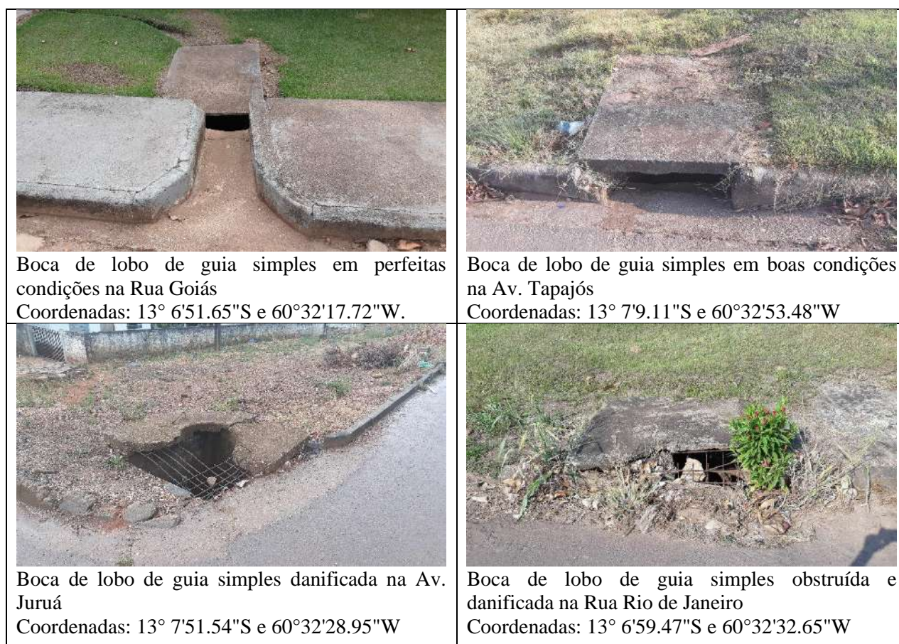
Figura 152 – Exemplos dos tipos e estado de conservação das bocas de lobo de Colorado do Oeste.
