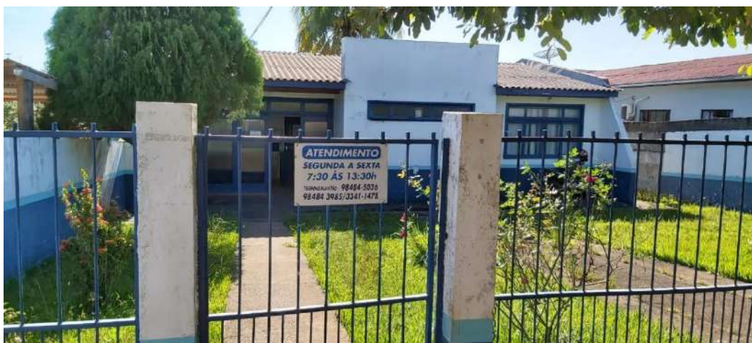
Figura 27 - Sede de apoio administrativo da CAERD de Colorado do Oeste.
