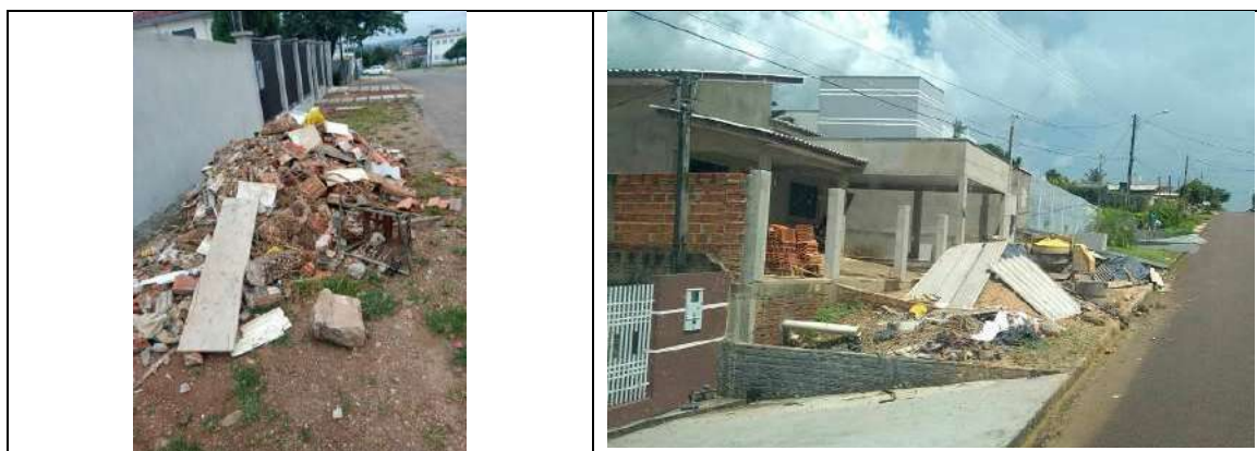
Figura 181 - Acondicionamento dos RCC
