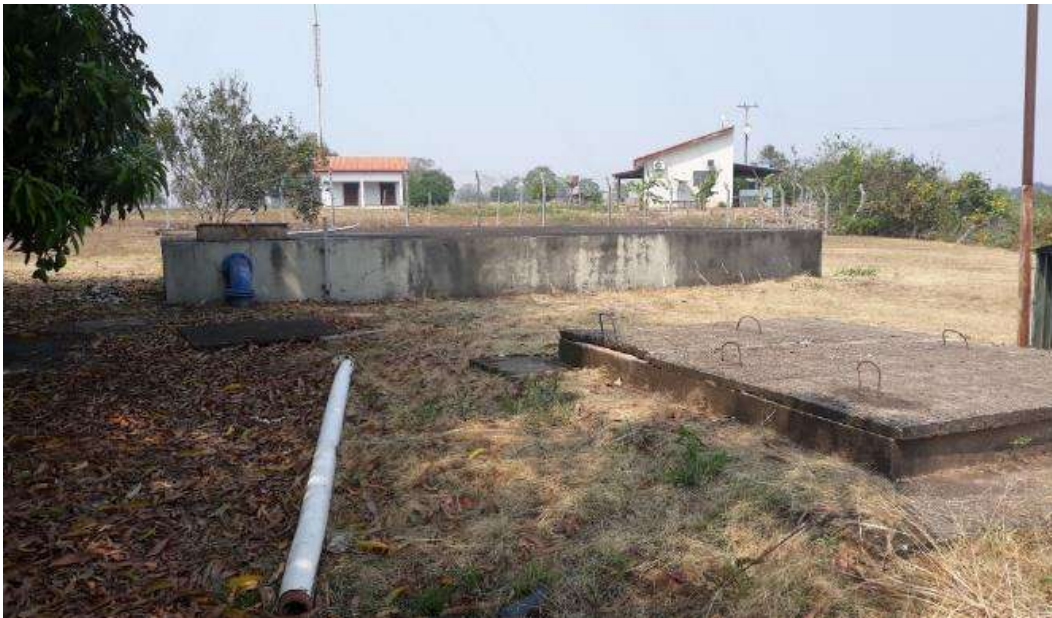
Figura 59 - Reservatório Enterrado 250 m 3 .
