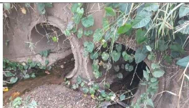
Rua Tupi – bueiro, 2 manilhas de 1m Coordenadas: 13°07'49.60"S e 61°32'26.07"W
