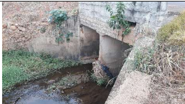
Rua Tupi - Galeria Dupla de 4m x 3m x 6m Coordenadas:13°07'31.60"S e 60°32'28.59"W
