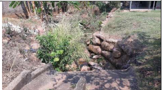
Rua Santa Catarina – 1 lado do canal retificado com pedras Coordenadas: 13°06'57.90"S e 60°32'40.63"W
