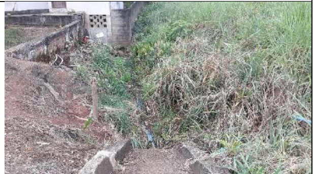
Rua Tapuias Coordenadas: 13°07'22.12"S e 61°32'23.31"W
