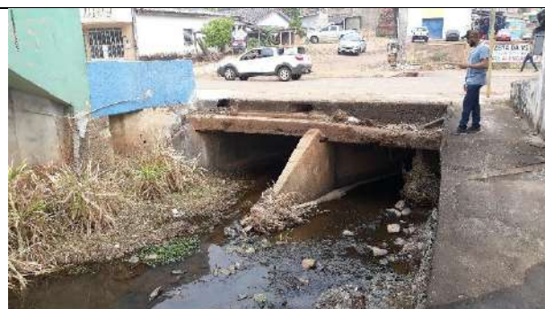
Rua Potguara - Galeria dupla 6m x 2m x 6m Coordenadas:13°07'34.84"S e 60°32'35.33"W
