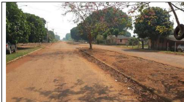
Figura 155 – Meio fio e Sarjetas em Colorado do Oeste.
