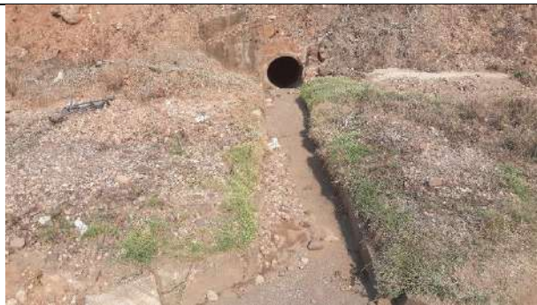
Bueiro de saída na Rua Mognopolis Coordenadas: 13° 7'53.82"S e 60°32'41.41"W
