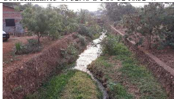
Rua Nu Aruaques - Canal retificado nas 2 laterais com pedra Coordenadas: 13°07'32.55"S e 60°32'18.66"W
