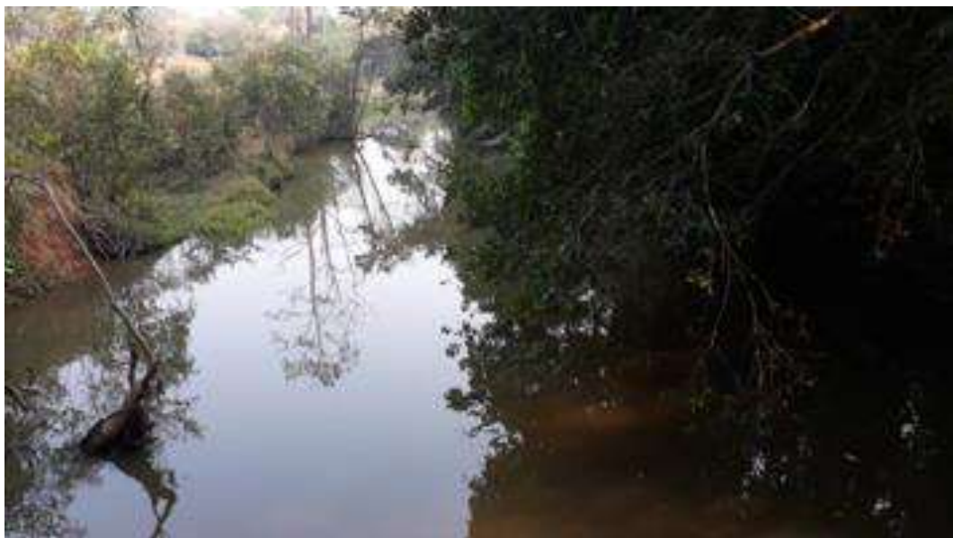
Figura 30 - Vista do manancial a montante da captação.
