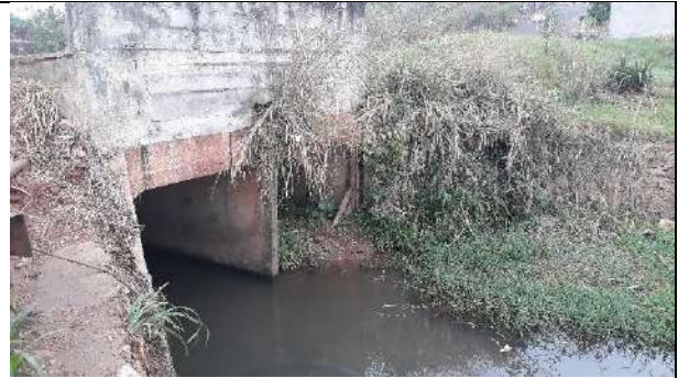
Rua Nu Aruaques - Galeria Dupla de 4m x 2m x 6m Coordenadas:13°07'31.25"S e 60°32'22.07"W
