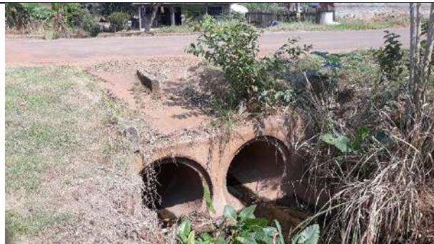
Rua Santa Catarina – 2 manilhas de 0,80m Coordenadas: 13°06'57.90"S e 60°32'40.63"W
