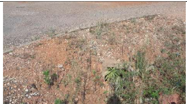
Bueiro de saída na Av. Rio Madeira Coordenadas: 13° 7'46.51"S e 60°32'45.61"W
