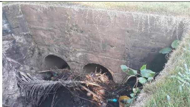
Rua Nognopolis – 3 manilhas de 0,8m de diâmetro Coordenadas: 13°07'02.85"S e 60°32'47.20"W
