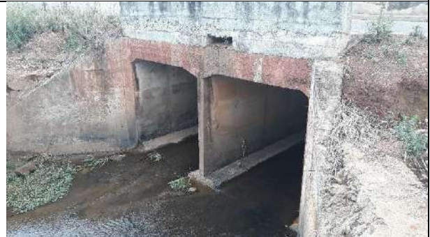
Rua Guarani - Galeria Dupla de 4m x 3m x 6m Coordenadas:13°07'29.09"S e 60°32'25.47"W
