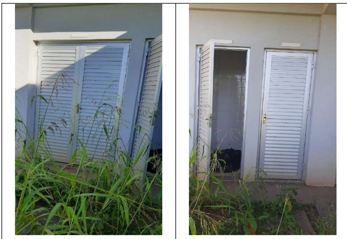
Figura 184 – Vistas do abrigo de armazenamento temporário de RSS da UBS Josie Antônio de Souza
