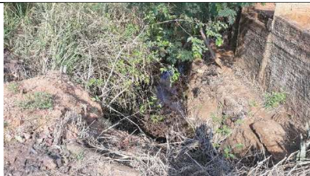
Rua Cabixi - Canal Retificado com pedras Coordenadas: 13°07'08.48"S e 60°33'00.84"W
