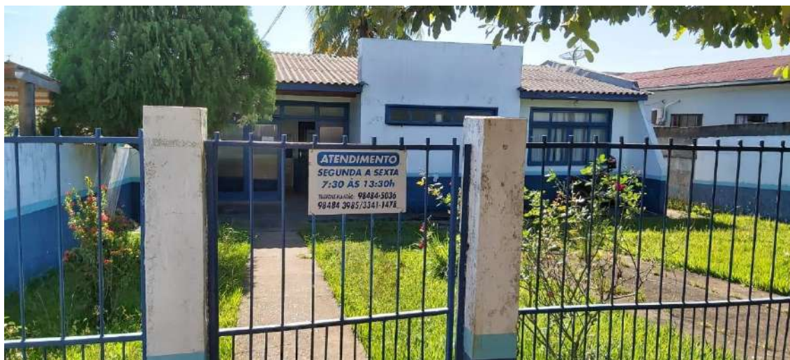
Figura 25 – Estação de Tratamento de Água em Colorado do Oeste.
