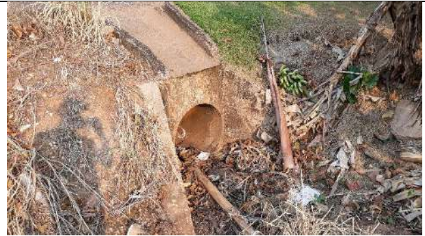
Bueiro de saída na Rua São Paulo Coordenadas: 13° 7'7.86"S e 60°32'8.76"W
