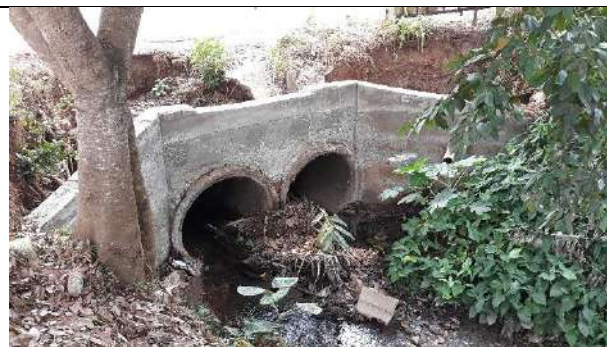
Av. Solimões – bueiro, 2 manilhas de 1m Coordenadas: 13°07'37.40"S e 61°32'33.41"W
