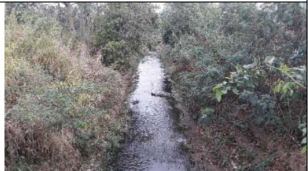
Rua Tupi - Canal retificado nas 2 laterais com pedra Coordenadas:13°07'31.51"S e 60°32'28.82"W
