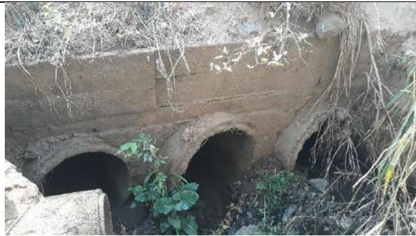
Rua Cabixi - 3 manilhas de 0,8m de diâmetro Coordenadas: 13°07'08.48"S e 60°33'00.84"W
