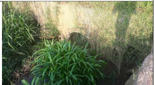
Rua Tiradentes – 4 manilhas de 1m de diâmetro Coordenadas: 13°07'04.50"S e 60°32'51.09"W
