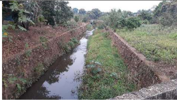
Rua Tapuias - Canal retificado nas 2 laterais com pedra Coordenadas:13°07'31.24"S e 60°32'21.78"W
