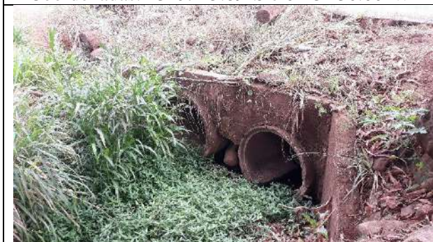
Av. Rio Madeira – bueiro, 2 manilhas de 1m Coordenadas: 13°07'44.53"S e 61°32'31.69"W
