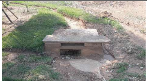
Boca simples em boas condições Coordenadas: 13° 7'19.15"S e 60°32'46.80"W
