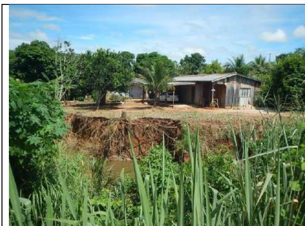
Avenida Juruá esquina com Rua Tupi Fonte: CPRM (2016)
