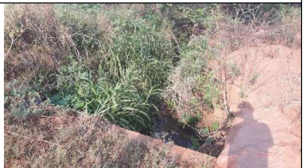
Rua dos Parecis - Canal Retificado com pedras Coordenadas: 13°07'06.63"S e 60°32'54.20"W
