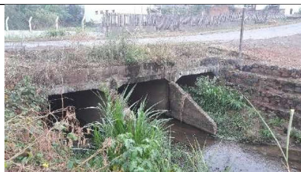
Rua Humaitá - Galeria tripla 6m x 2m x 6m Coordenadas:13°07'32.04"S e 60°32'31.91"W
