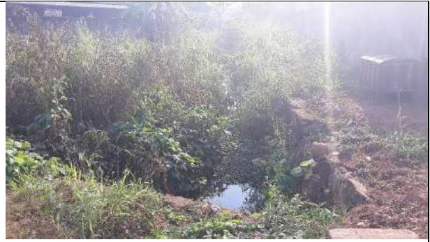
Rua dos Parecis - Canal Retificado com pedras Coordenadas: 13°07'06.63"S e 60°32'54.20"W
