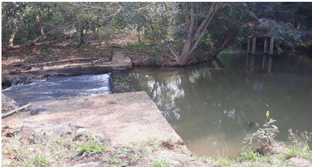
Figura 35 – Barragem de nível na captação do SAA da Sede Municipal.
