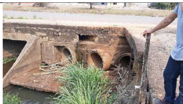
Av.Mal.Rondon – 3 manilha de 1m de diâmetro Coordenadas:13°07'33.41"S e 60°32'38.41"W
