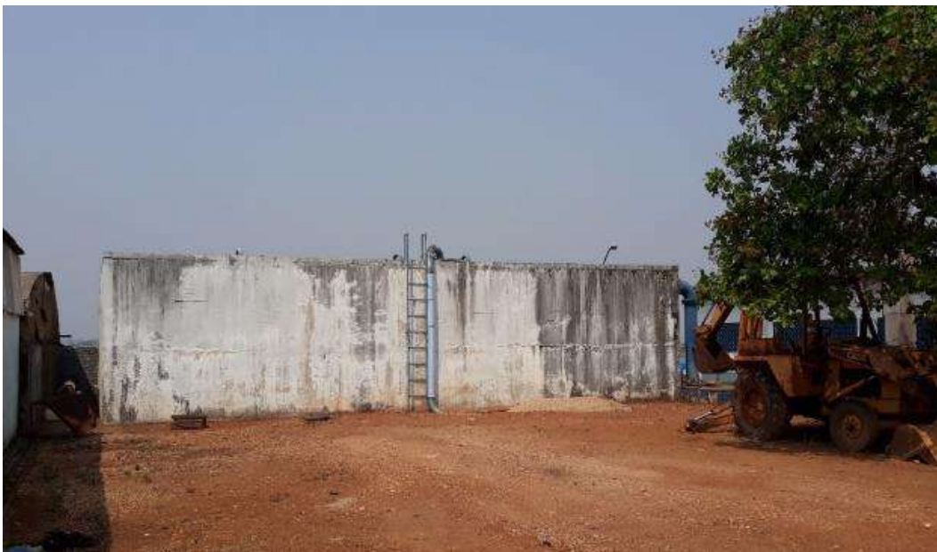
Figura 60 - Reservatório apoiado 500 m 3 .
