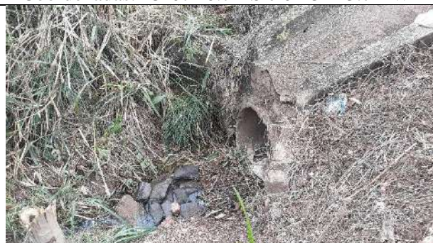
Rua Tapuias – bueiro, manilha de 0,80m Coordenadas: 13°07'22.11"S e 61°32'23.12"W
