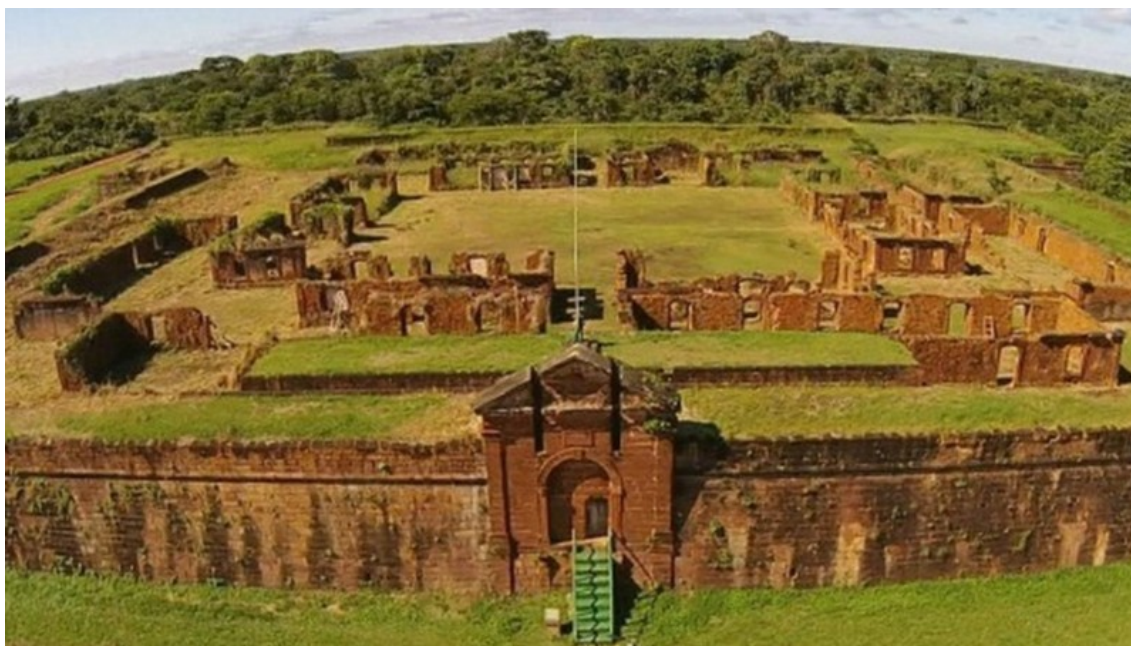
Figura 4 — Vista Frontal do Forte Príncipe da Beira, em Costa Marques
