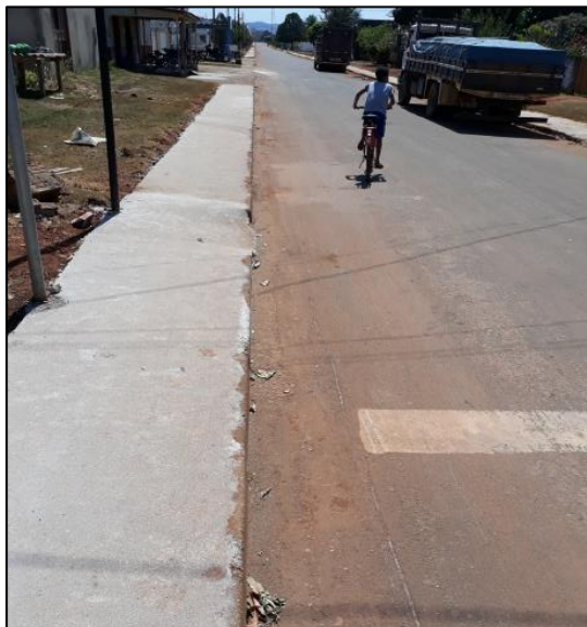
Figura 182 - Meio-fio e sarjeta, Av. Tapajós.
