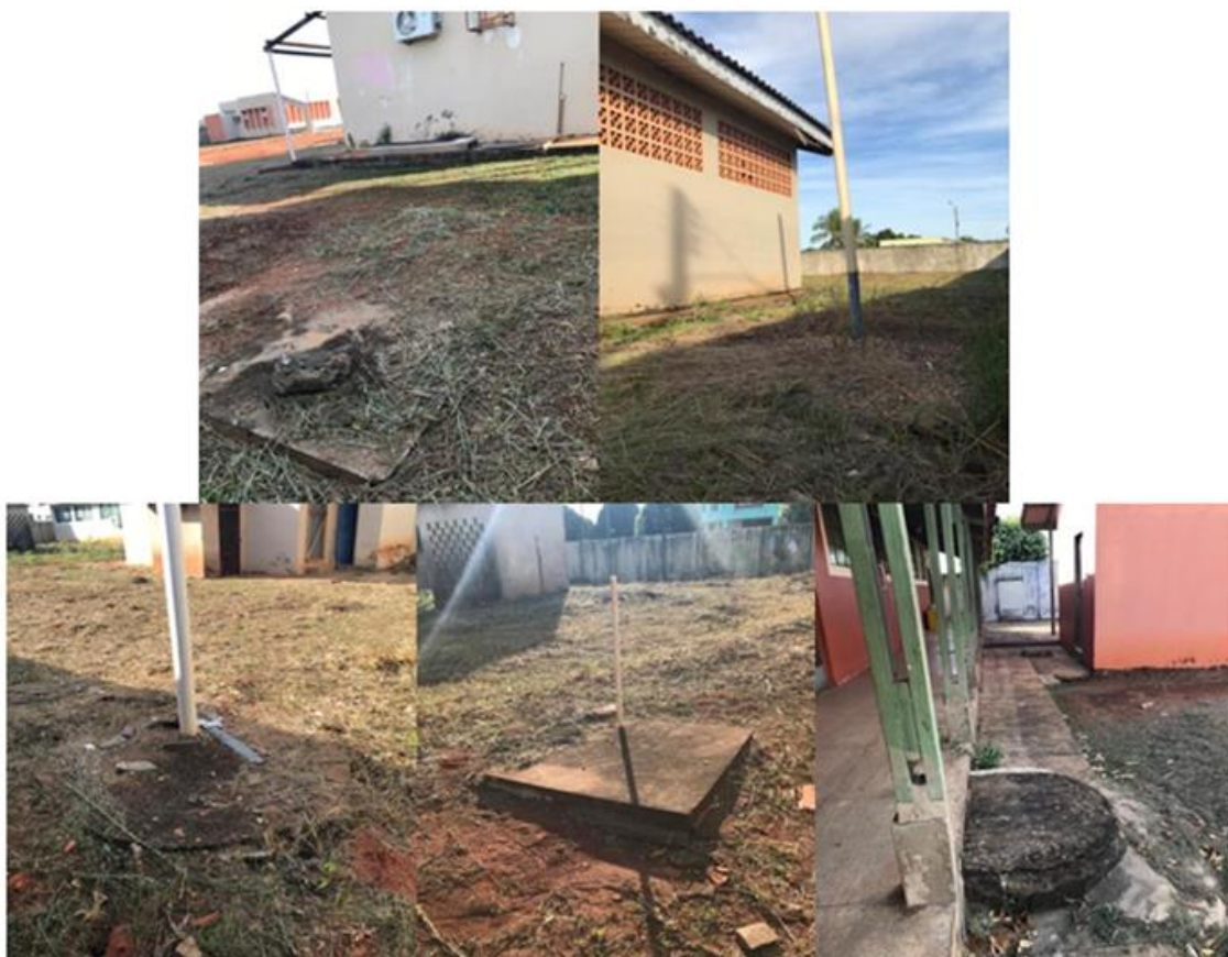
Figura 151 - Fossas rudimentares da Escola José de Anchieta, na Sede Municipal.
