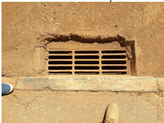
Figura 188 - Boca de lobo da RO-497, em bom estado de conservação.
