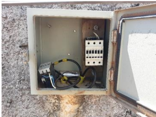
Figura 98 - Chave de acionamento do poço Vila Neide
