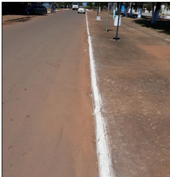
Figura 181 - Meio-fio e sarjeta, Av. Tupinambás.
