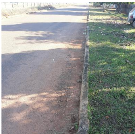
Figura 199 - Meio-fio e sarjeta em boas condições estruturais na linha 2º eixo escondido em Estrela do Oeste.
