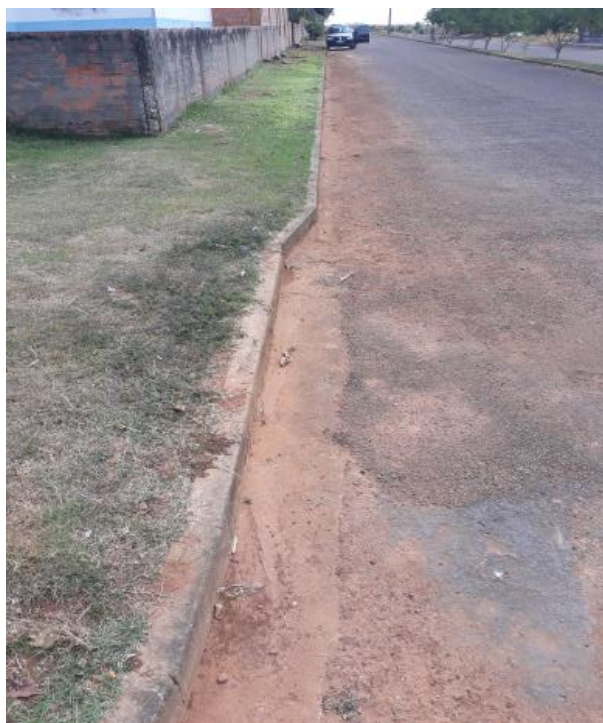
Figura 196 - Meio-fio e sarjeta em boas condições na rua Mato Grosso em Planalto São Luiz.
