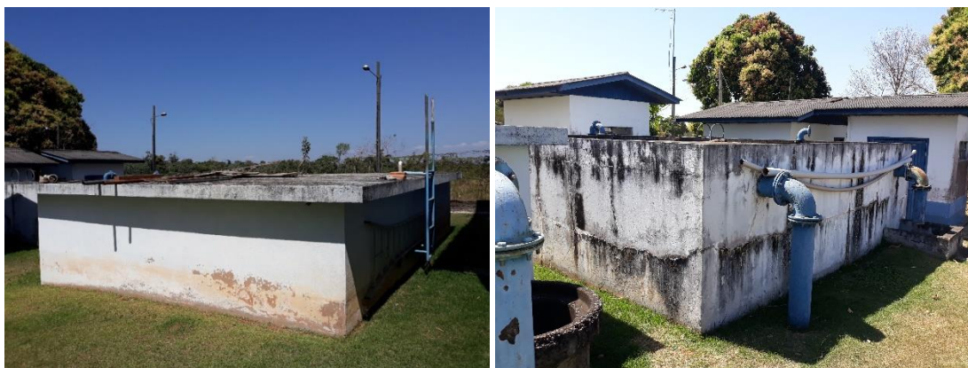
Figura 50 - Reservatórios de Contato
