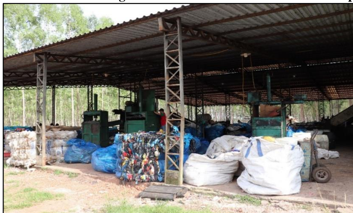
Figura 228 - Central de triagem do aterro sanitário encontra-se em operação.
