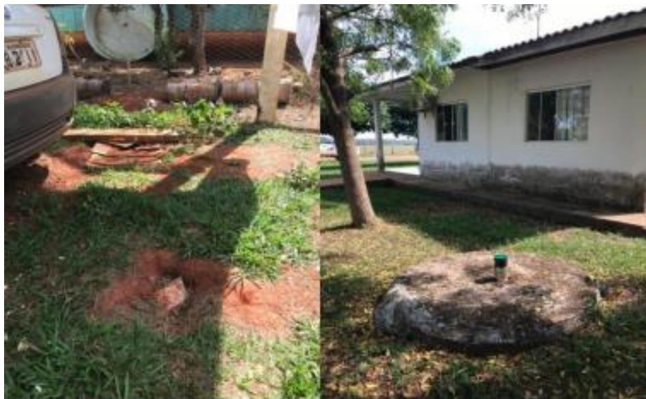
Figura 158 – Fossa rudimentar circular do Centro de Saúde Tiradentes, Distrito Estrela do Oeste.
