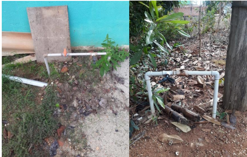
Figura 111- Ligações domiciliares de água da Vila Neide
