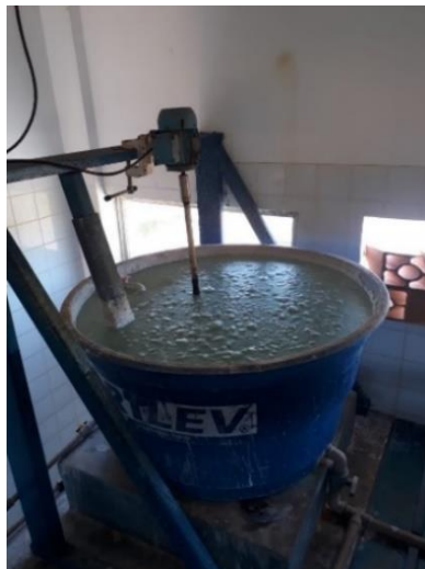
Figura 54 - Preparo da cal hidratada
