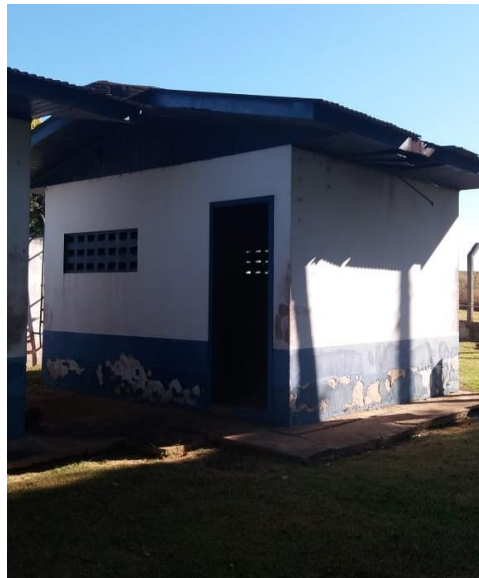
Figura 58 - Vista do abrigo da EEAT 02.
