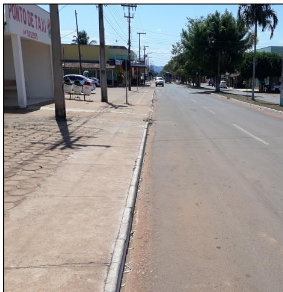
Figura 184 - Meio-fio e sarjeta, Av. Tupinambás.
