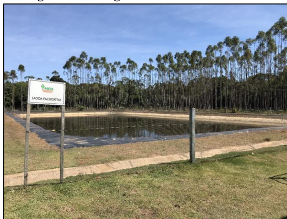
Figura 229 - Lagoa facultativa do efluente.
