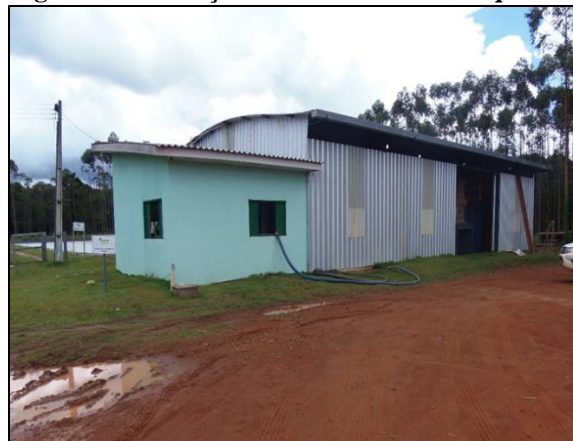
Figura 230 - Estação de tratamento físico-químico.
