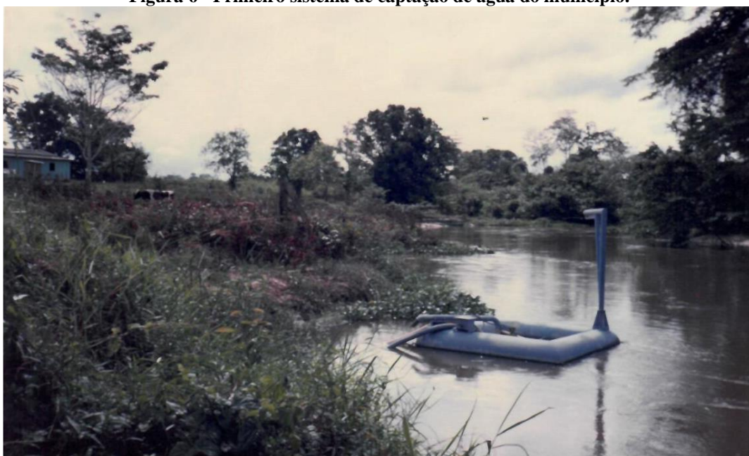
Figura 6 - Primeiro sistema de captação de água do município.
