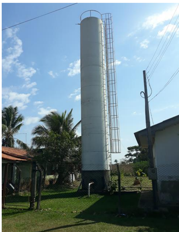
Figura 88 - Reservatório Planalto São Luiz
