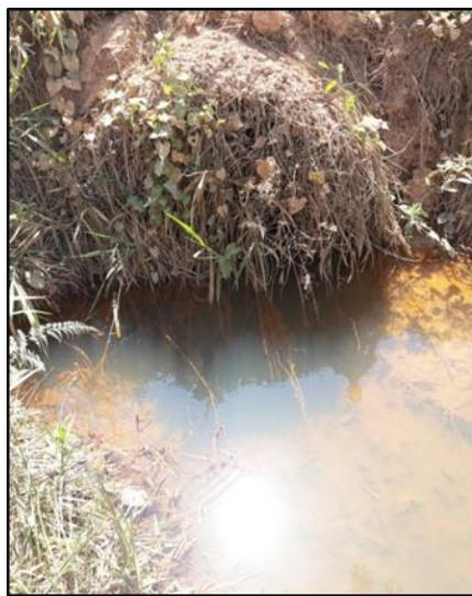
Bueiro 1 - Bueiro tubular simples de tubo Armco de 1m de diâmetro e 12 m de comprimento, na linha 11 Colorado.
