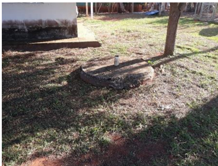
Figura 144 - Fossa rudimentar no distrito Estrela do Oeste.
