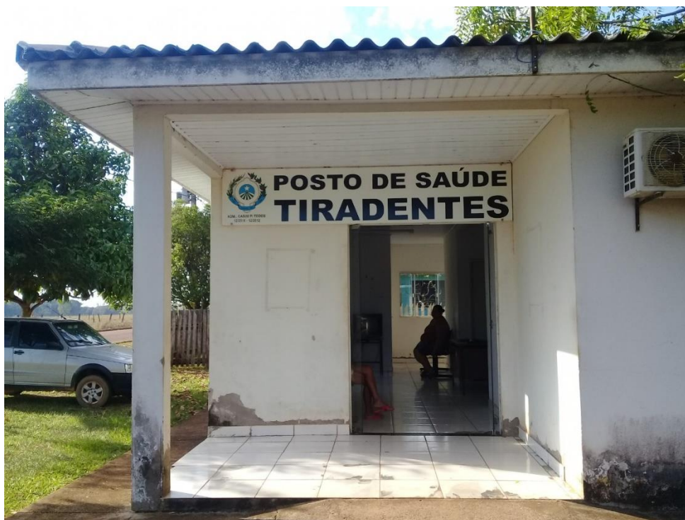
Figura 24 - Centro de Saúde Tiradentes, localizado na zona rural - Distrito Estrela do Oeste.
