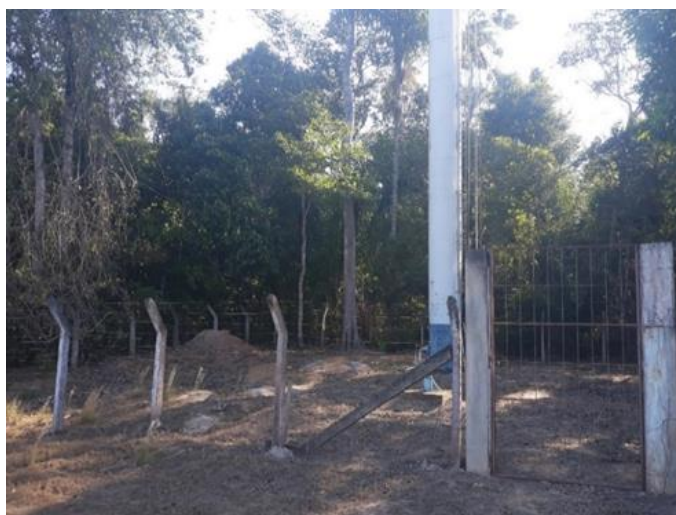
Figura 99 - Local do poço e reservatório de abastecimento de água da Vila São João.
