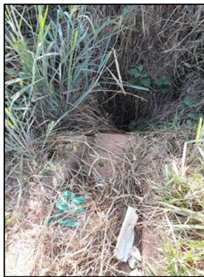
Bueiro 2 - Local onde inicia um bueiro tubular simples de tubo de concreto de 1m de diâmetro e 12 m de comprimento, na avenida Guarani.
