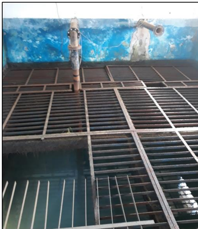
Figura 80 - Tubo de sucção do EEAB Planalto São Luiz.
