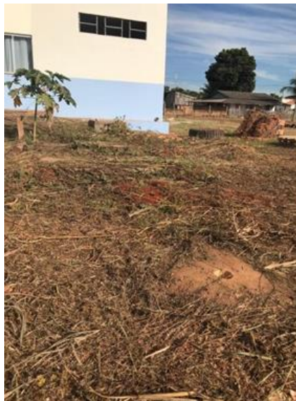
Figura 155 – Fossa rudimentar da APAE, na Sede Municipal.
