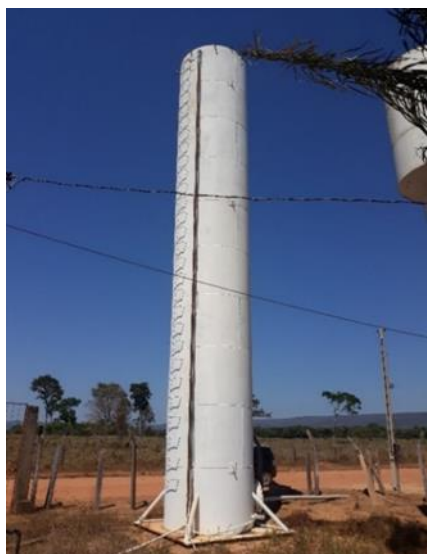
Figura 104 - Reservatório Vila Neide.
