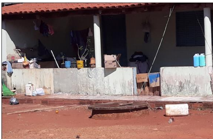
Figura 113 - Poço amazonas no Distrito Estrela do Oeste
