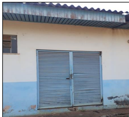
Figura 244 - Vista externa do abrigo de armazenamento temporário de RSS.
