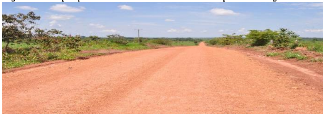
Figura 51 – Recuperação de 48 km de estradas vicinais do município de Alto Alegre dos Parecis
