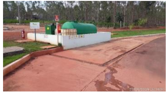
Posto de abastecimento
