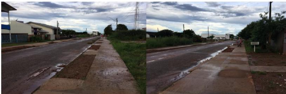
Figura 48 – Construção de calçada de passeio na sede municipal de Alto Alegre dos Parecis
