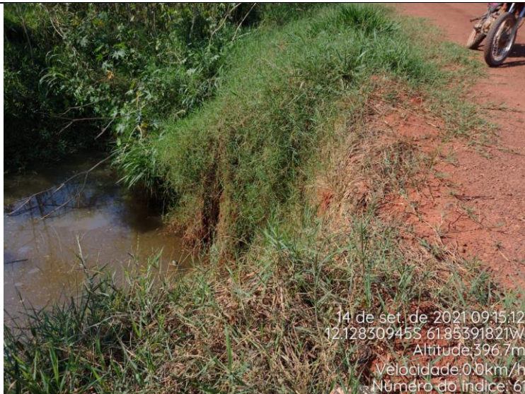
Rua Deodoro da Fonseca
