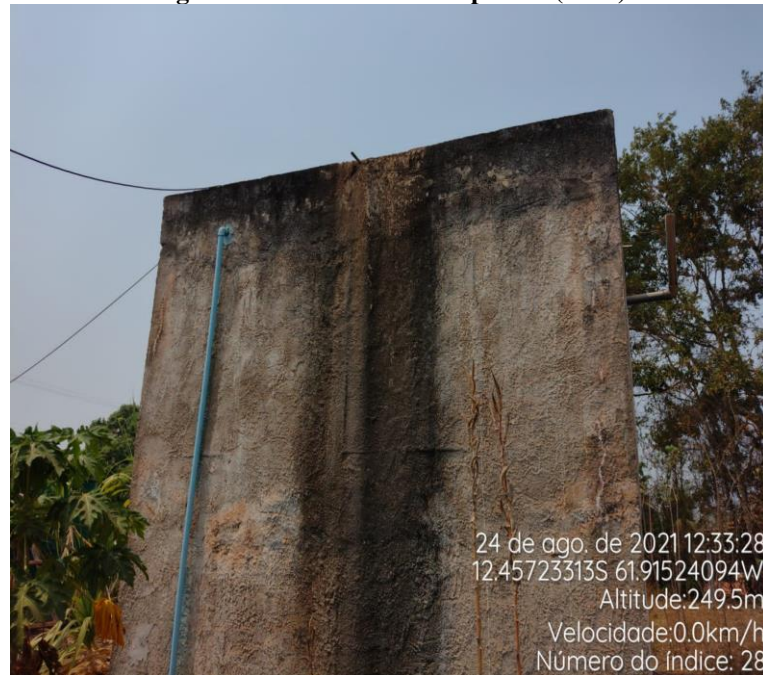
Figura 105 - Reservatório Apoiado (RAP)
