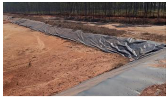
Sistema de impermeabilização das células
