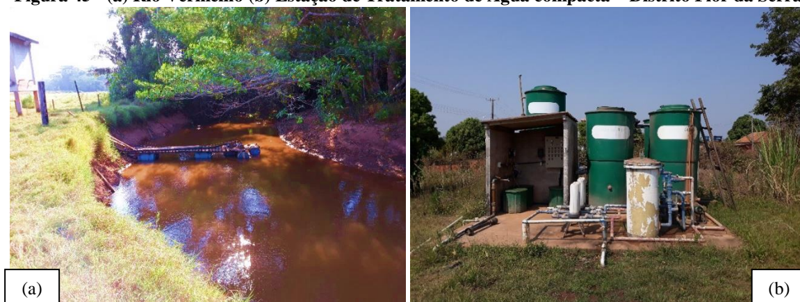
Figura 45 - (a) Rio Vermelho (b) Estação de Tratamento de Água compacta – Distrito Flor da Serra
