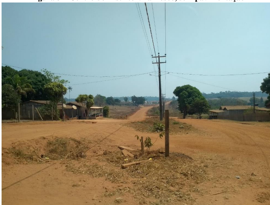
Figura 3 – Centro do Distrito Vila Bosco, sem pavimentação
