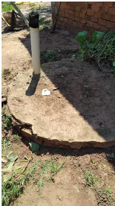
Figura 158 - Fossa rudimentar no distrito Bosco - Rua Antônio Ribeiro
