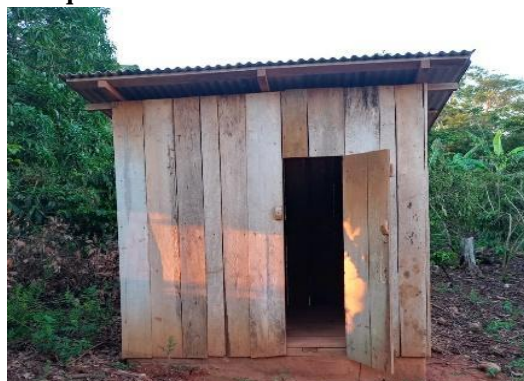
Fossa seca - Linha P42 km 3 11°10'11.29"S e 61°28'6.17"W
