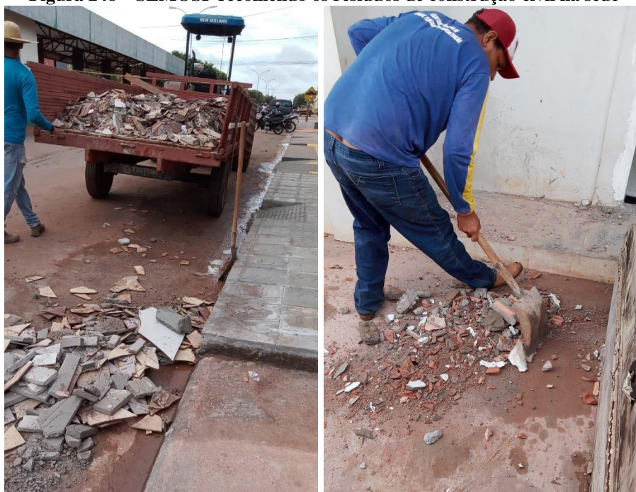
Figura 248 – SEMOSP recolhendo os resíduos de construção civil na sede
