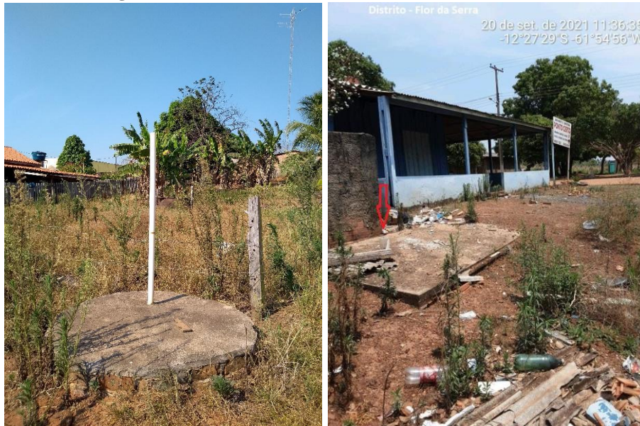
Figura 156 - Fossa rudimentar no distrito Flor da Serra
