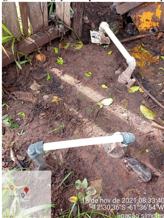
Figura 129 – Ligações simples sem micromedição
