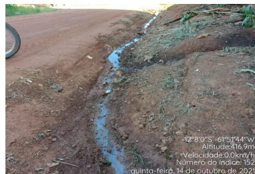
Despejo de águas cinzas à céu aberto Coordenadas geográficas 12°08'03.00"S e 61°51'09.00"W
