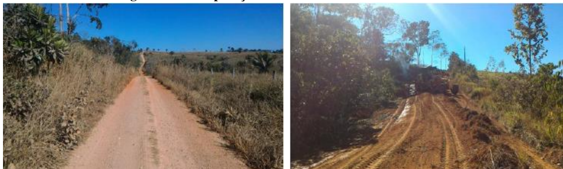
Figura 53 - Recuperação das estradas vicinais da linha P34
