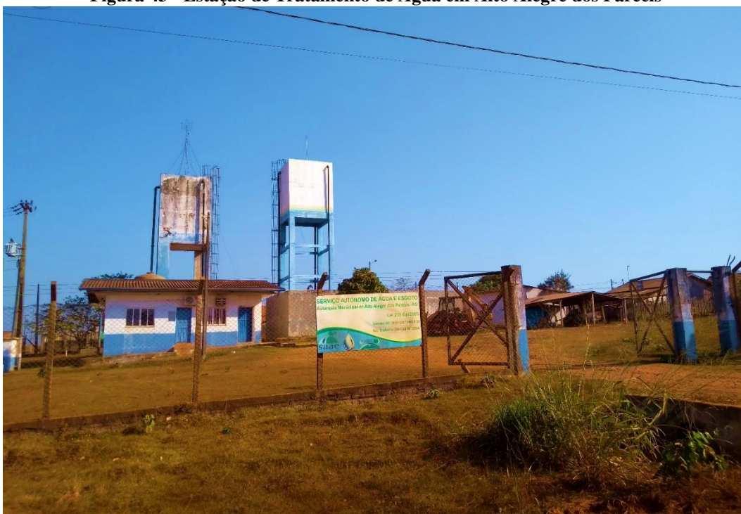
Figura 43 - Estação de Tratamento de Água em Alto Alegre dos Parecis
