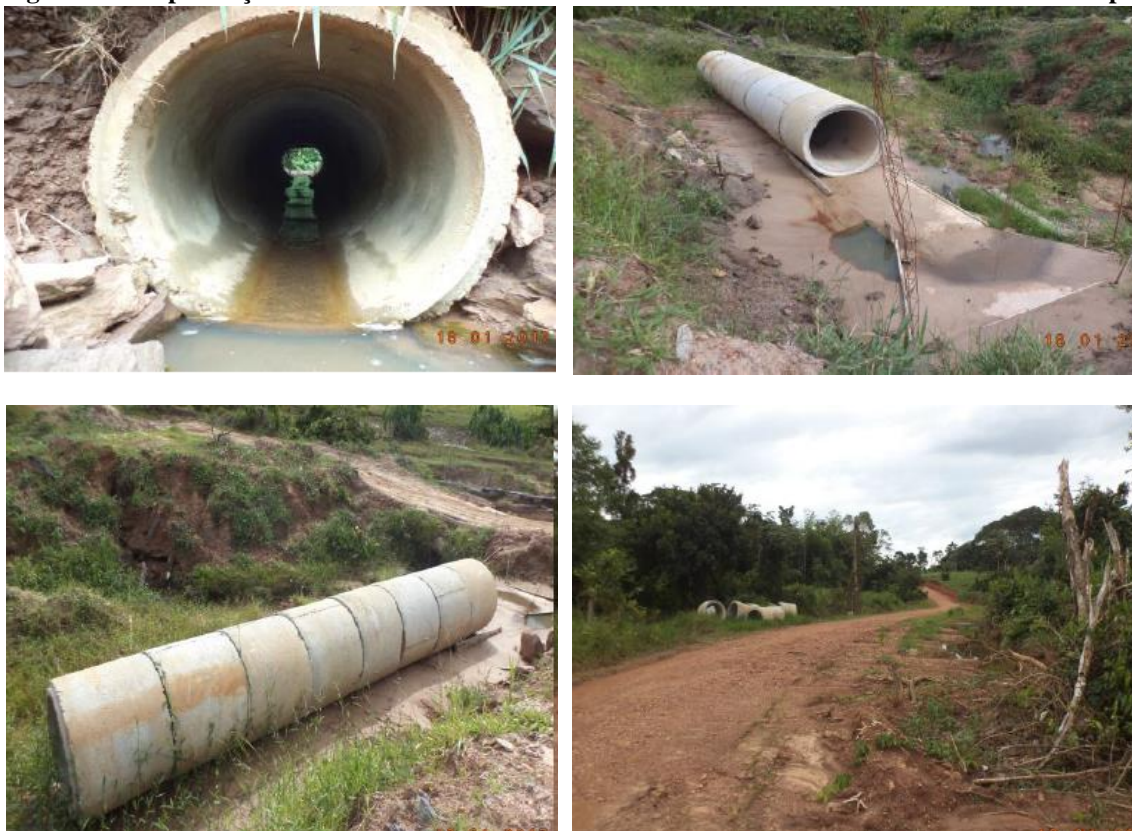
Figura 52 - Implantação de manilhas em localidade de baixo nível nas estradas vicinais do município
