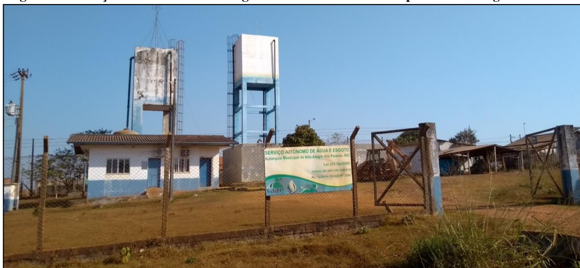
Figura 64 - Estação de Tratamento de Água do SAA da Sede Municipal de Alto Alegre dos Parecis
