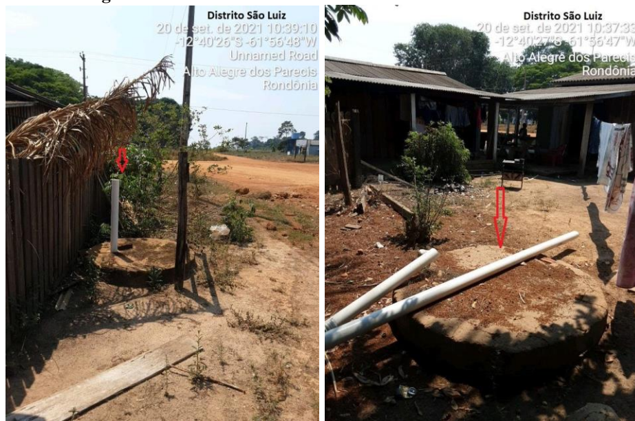
Figura 160 – Fossas rudimentares na Vila São Luís da União
