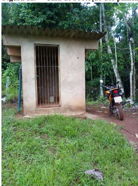
Figura 119 – Casa de Proteção dos paineis
