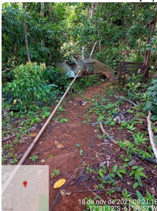
Figura 118 – Área onde se encontra o manancial de Captação Distrito Bosco
