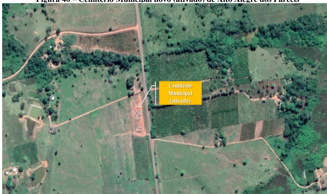
Figura 40 – Cemitério Municipal novo (ativado) de Alto Alegre dos Parecis
