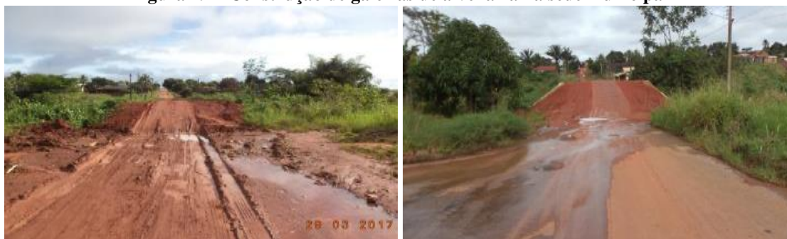
Figura 49 – Construção de galerias de alvenaria na sede municipal
