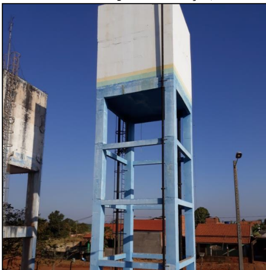
Figura 81 - Reservatório elevado em fase de impermeabilização, na área da ETA da Sede Municipal.
