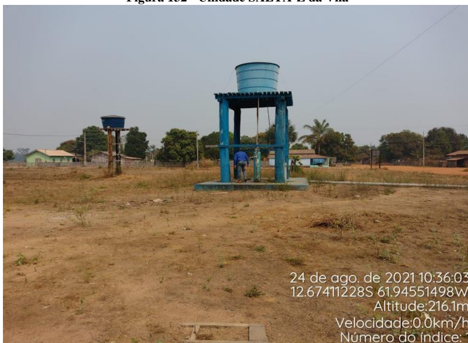
Figura 132 - Unidade SALTA-Z da Vila
