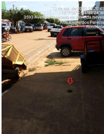
Fossa rudimentar – Av. Tancredo Neves 12°07'56.00\"S e 61°51'24.00\"W
