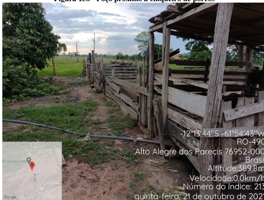
Figura 138 - Poço próximo a chiqueiro de porcos
