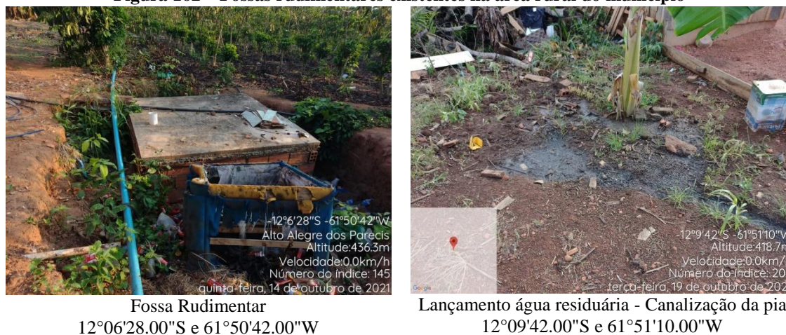
Figura 162 – Fossas rudimentares existentes na área rural do município
