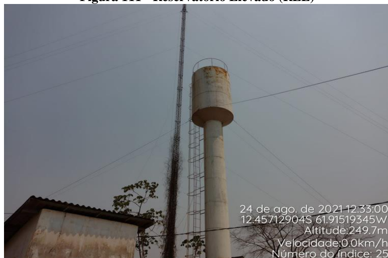
Figura 111 - Reservatório Elevado (REL)
