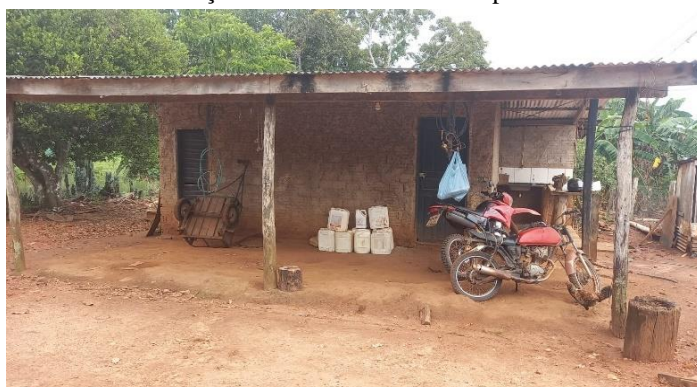
Paiol para armazenamento das embalagens
