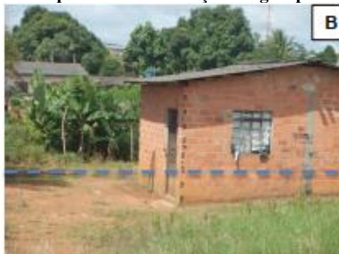
B - Residência de alvenaria em planície de inundação de igarapé, marca de inundação de aproximadamente 0,5m
