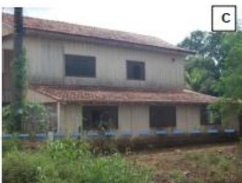
C - Residência de alvenaria em planície de inundação de igarapé, marca de inundação de aproximadamente 0,5m;
