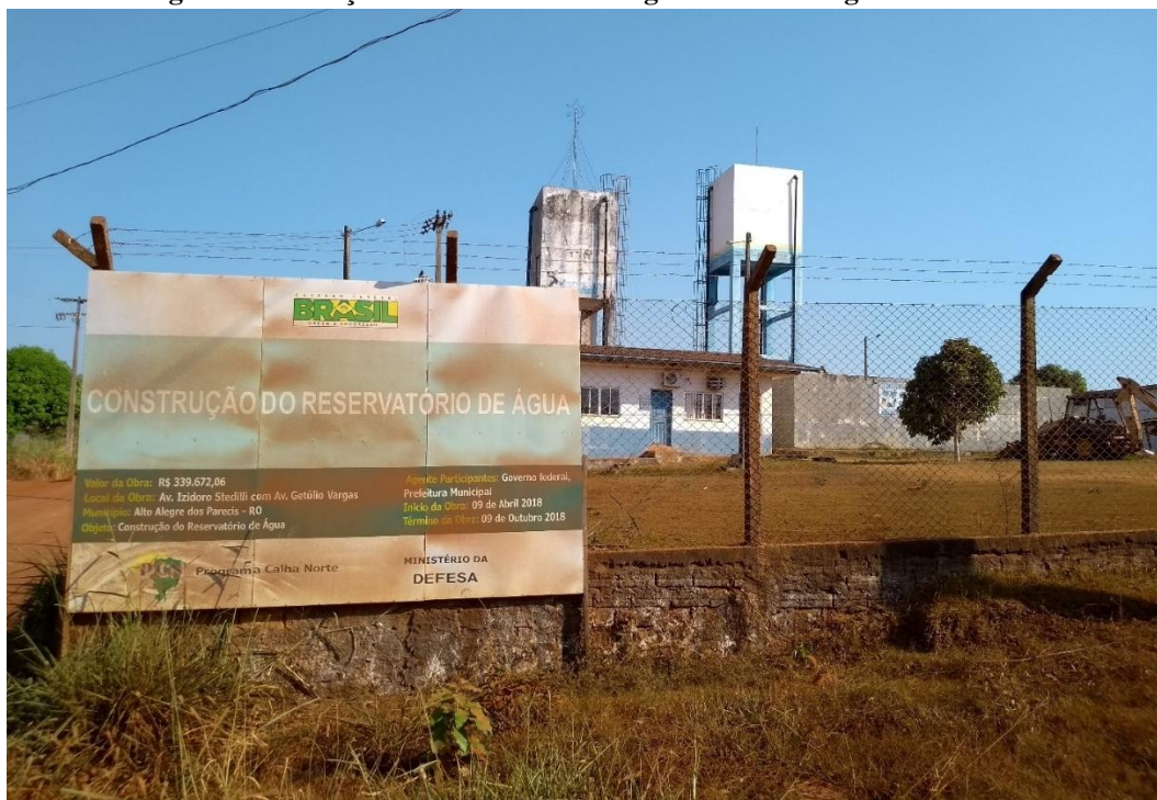
Figura 44 - Estação de Tratamento de Água em Alto Alegre dos Parecis
