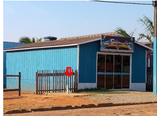
Fossa rudimentar – Rua Tiradentes 12°07'43.00\"S e 61°51'27.00\"W
