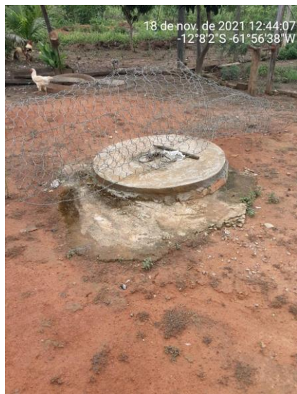
Linha P 70 km 8 – Poço amazonas Coordenadas geográficas 12°08'02.00\"S e 61°56'38.00\"W
