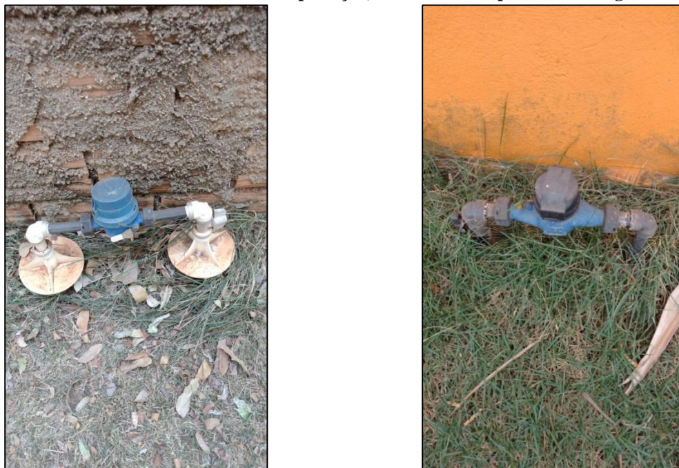
Figura 84 - Cavaletes com hidrômetros sem proteção, na Sede Municipal de Alto Alegre dos Parecis.
