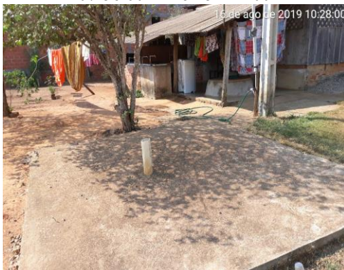
Fossa rudimentar – Rua Tiradentes 12° 7'45.05\"S e 61°51'27.93\"W
